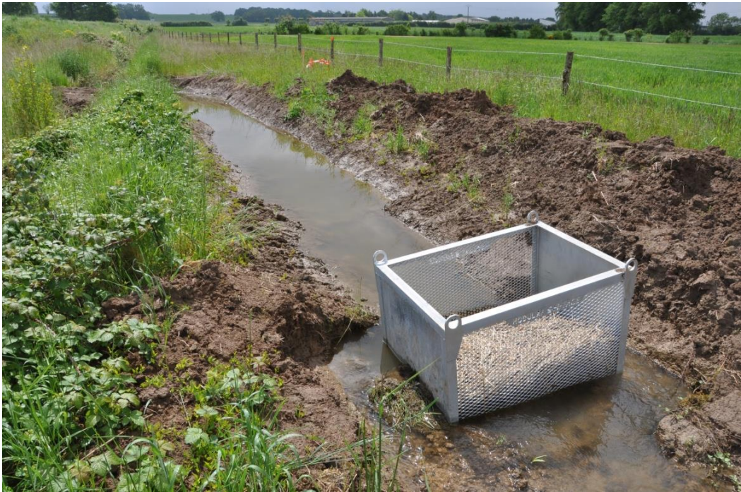
Photographie 2 : Exemple de mise en place de filtre à paille sur un ruisseau (photo : Eco-stratégie)
