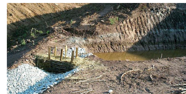
FIGURE 16 : EXEMPLE DE FILTRE A PAILLE Source : Scéteauroute
