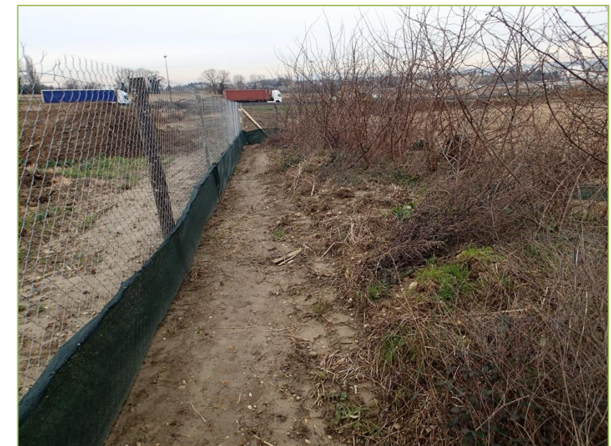
Photographie 9 : Exemple de mise en défens d'un chantier vis-à-vis des reptiles, amphibiens et petite faune (source : Eco-stratégie)
