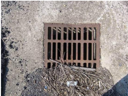
PHOTO 8 : EXEMPLE DE GRILLE AVALOIR UTILISEE POUR L'ASSAINISSEMENT ROUTIER SUR LA ZONE D'ETUDE Source : Milieu physique, Saunier et associés, 2012
