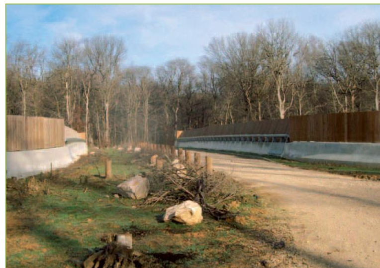
Photographie 8 : Exemple de passage à faune mixte supérieur (source : LGV Rhin-Rhône)
