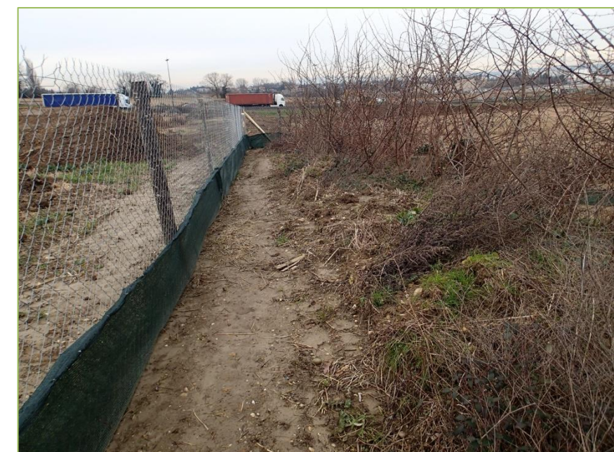
Exemple de mise en défens d'un chantier vis-à-vis des reptiles, amphibiens et petite faune (source : Eco-stratégie)
