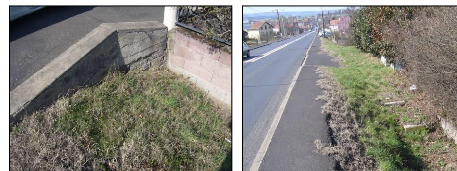
PHOTO 5 : EXEMPLE DE BUSES ET DE FOSSES ENTIÈREMENT BOUCHÉS DANS LA TRAVERSEE D'ARVANT
