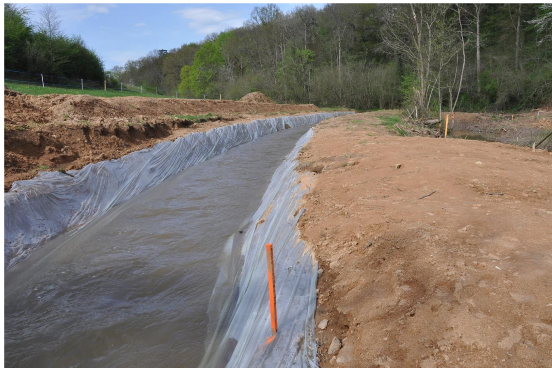
Photographie 6 : Exemple de surface bâchée lors de travaux (photo : Eco-stratégie)
