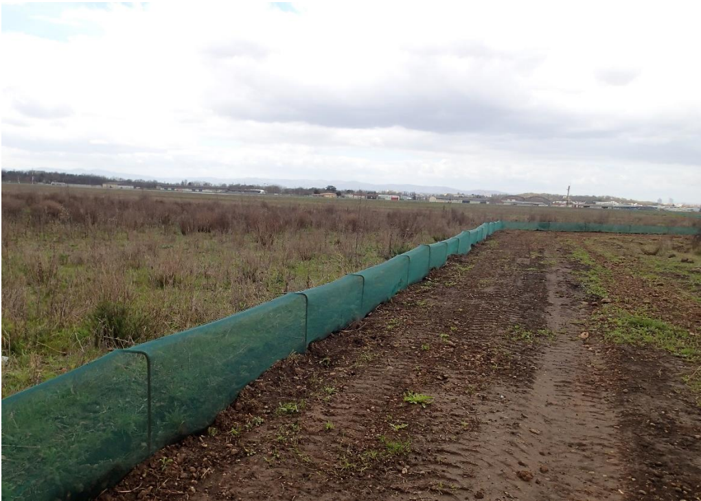
Photographie 5 : Exemple de clôture à mailles fines posée en limite du chantier (photo : Eco-stratégie)
