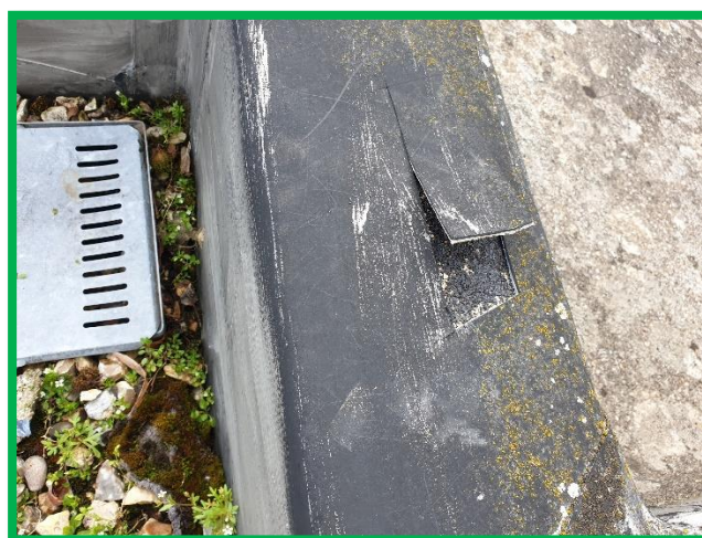
Prélèvement acrotère toiture poste écluse
