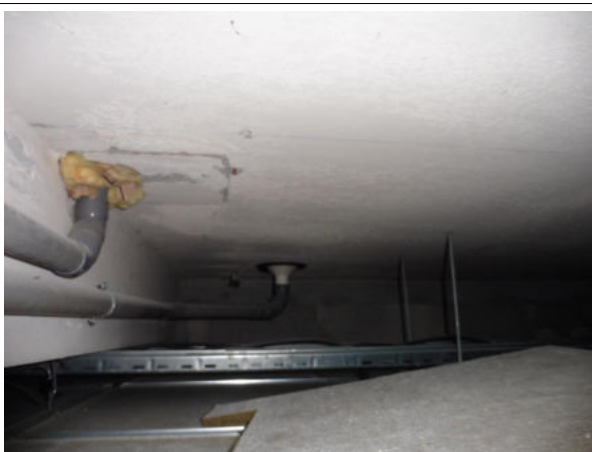
Prélèvement - P11 : RDC / 007 - Enduit- (Absence d'amiante)
