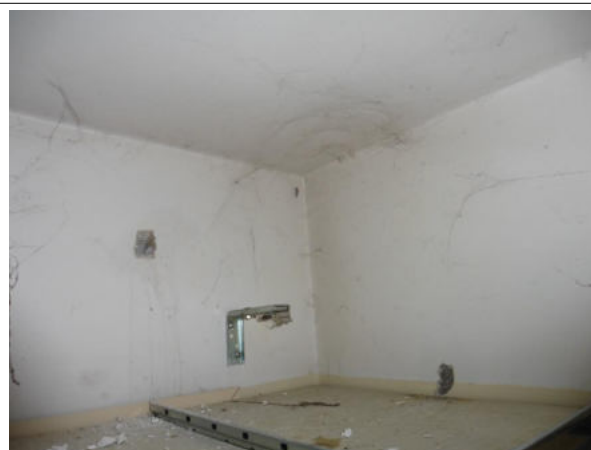
Prélèvement - P16 : RDC / 049 - Enduit- (Absence d'amiante)
