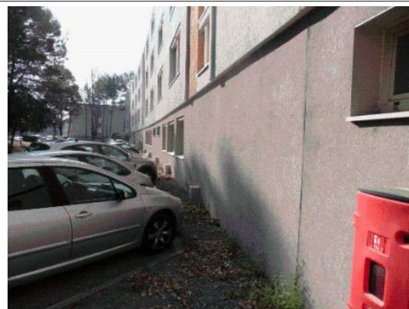
Prélèvement - P2 : EXTERIEUR / Façade avant - Enduit- (Absence d'amiante)
