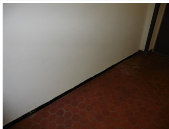
Prélèvement - P18 : RDC / 052 - Colle de plinthe- (Absence d'amiante)
