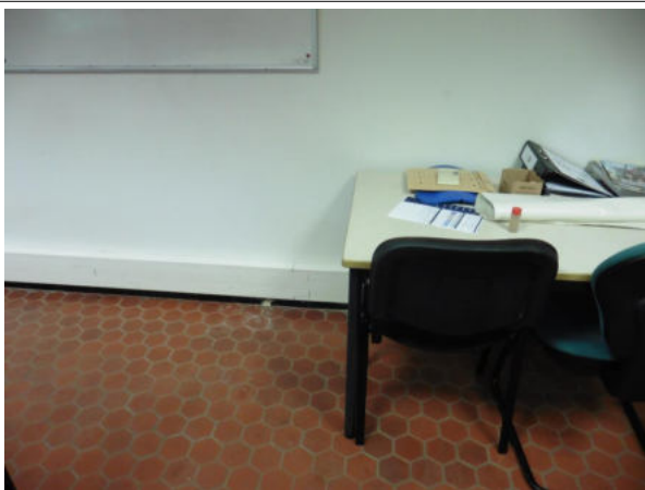
Prélèvement - P027 : RDC / 049 - Colle de plinthe- (Absence d'amiante)
