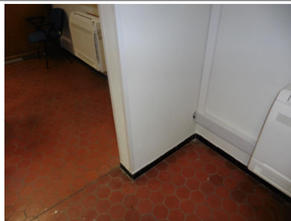
Prélèvement - P14 : RDC / 049 - Colle de plinthe- (Présence d'amiante)
