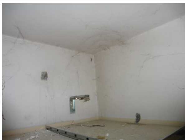
Prélèvement - P15 : RDC / 049 - Enduit- (Absence d'amiante)
