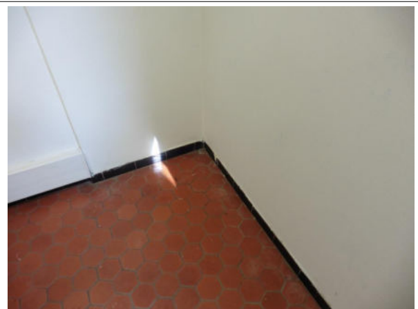
Prélèvement - P030 : RDC / 002 - Colle de plinthe- (Absence d'amiante)
