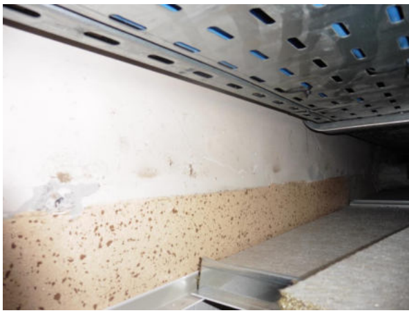
Prélèvement - P7 : RDC / 007 - Enduit- (Absence d'amiante)
