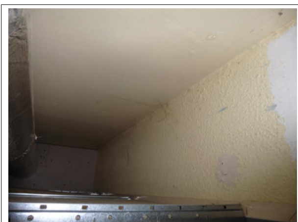
Prélèvement - P23 : RDC / 001 - Enduit- (Absence d'amiante)
