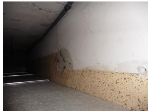
Prélèvement - P8 : RDC / 007 - Enduit- (Absence d'amiante)
