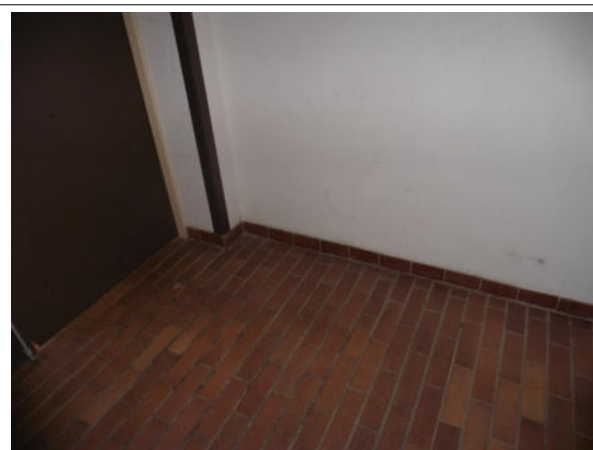
Prélèvement - P4 : RDC / 007 - Colle de plinthe- (Absence d'amiante)
