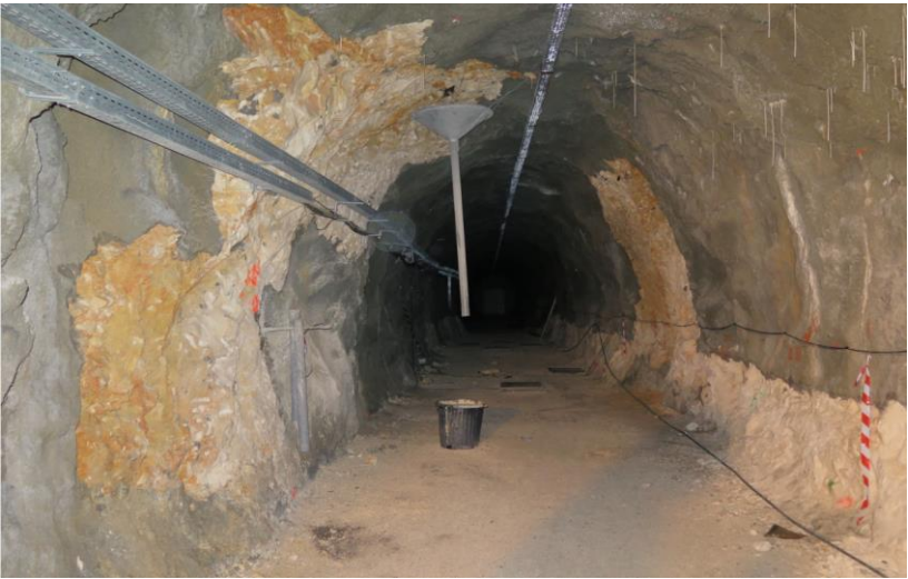
Figure 32 – Zone faillée dans la Galerie Anti-Souffle
