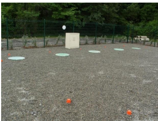
(Stockage de réservoirs enterrés et aériens desservant un réseau canalisé GPL)
