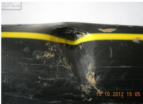
barre à mine / canalisation PEHD gaz MPB
