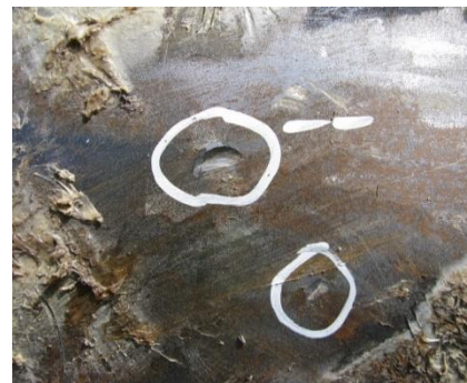
pioche / canalisation acier gaz HP
