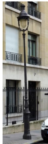
Éclairage public - Luminaire
