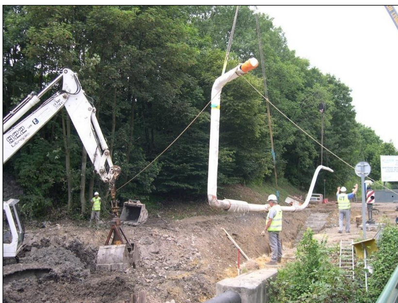
Illustration d'une baïonnette en cours de pose
