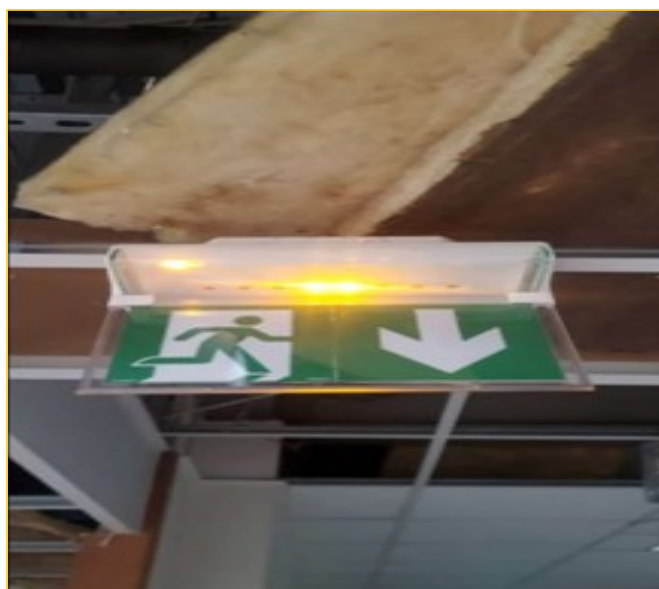
BAES – élément de sécurité. Réemploi en lieu et place
