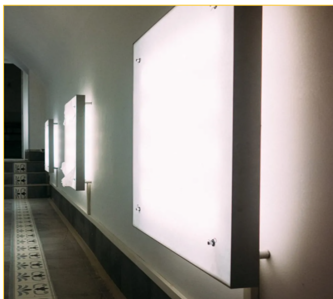
Dalle LED utilisée en panneau mural – Projet : Maison du Zéro Déchet
