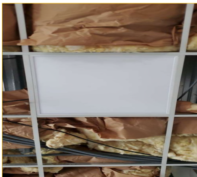
Réemploi sur rails de faux plafonds comme l'existant
