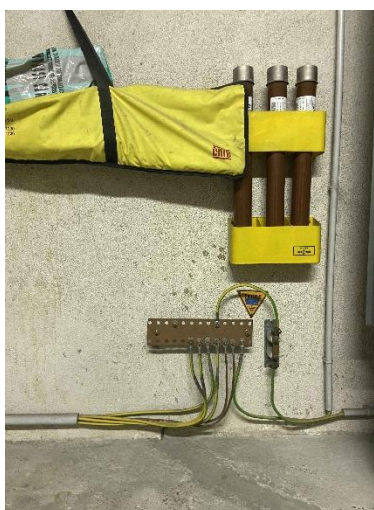
Figure 4 : Barrette de terre localisée dans le TGBT principal
