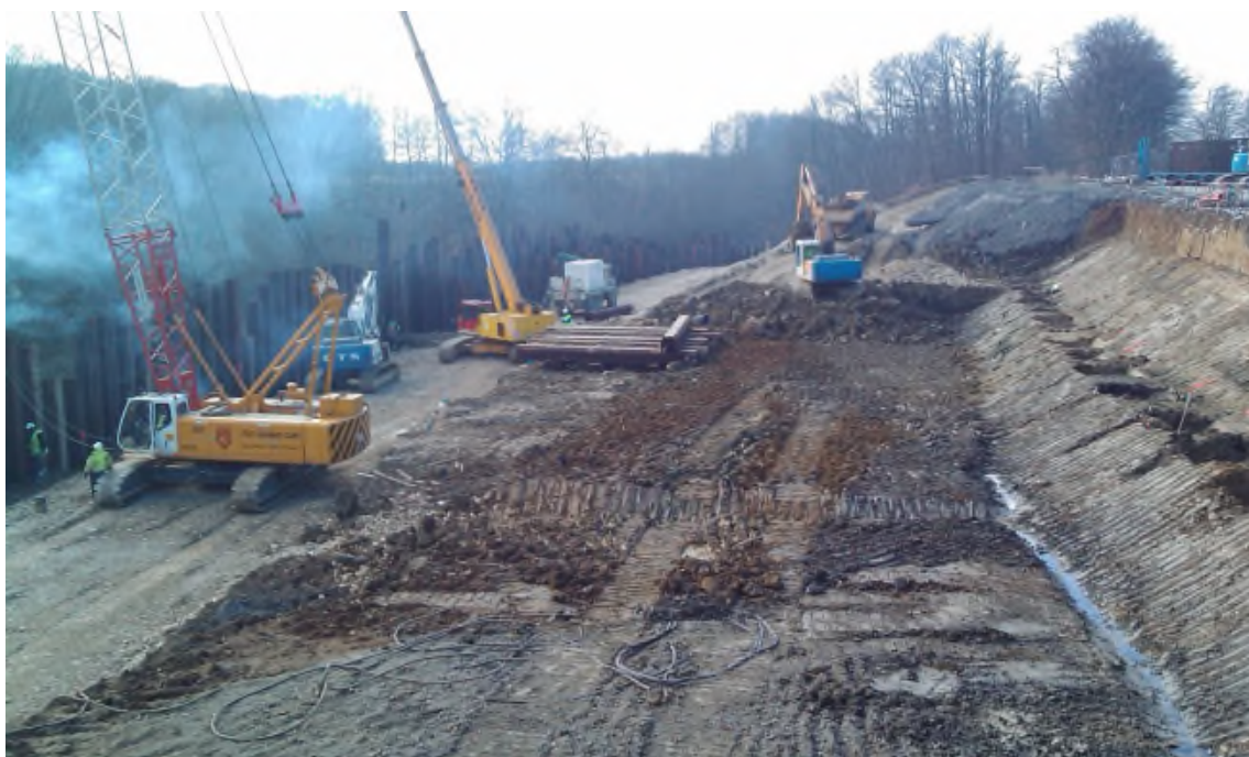
Figure 13 : terrassement et battage des palplanches. 29/02/2012.
