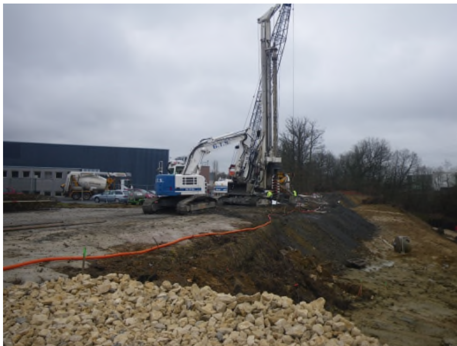
Figure 6 : forage des pieux. Photographie du 25/01/2012.
