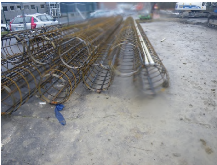
Figure 8 : forage des pieux et cages d'armatures. 25/01/2012.
