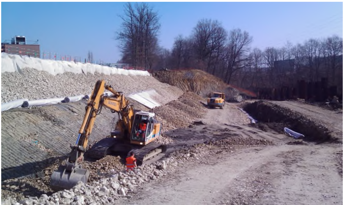
Figure 15 : couche granulaire en cours. 16/03/2012.
