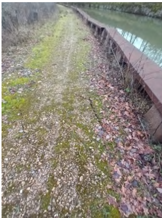
Figure 22 : déversement des palplanches. 05/01/2024.
