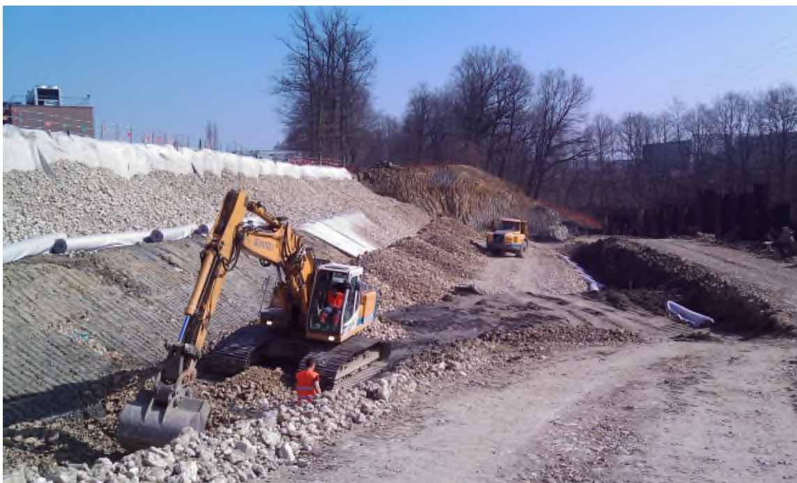
Figure 15 : couche granulaire en cours. 16/03/2012.
