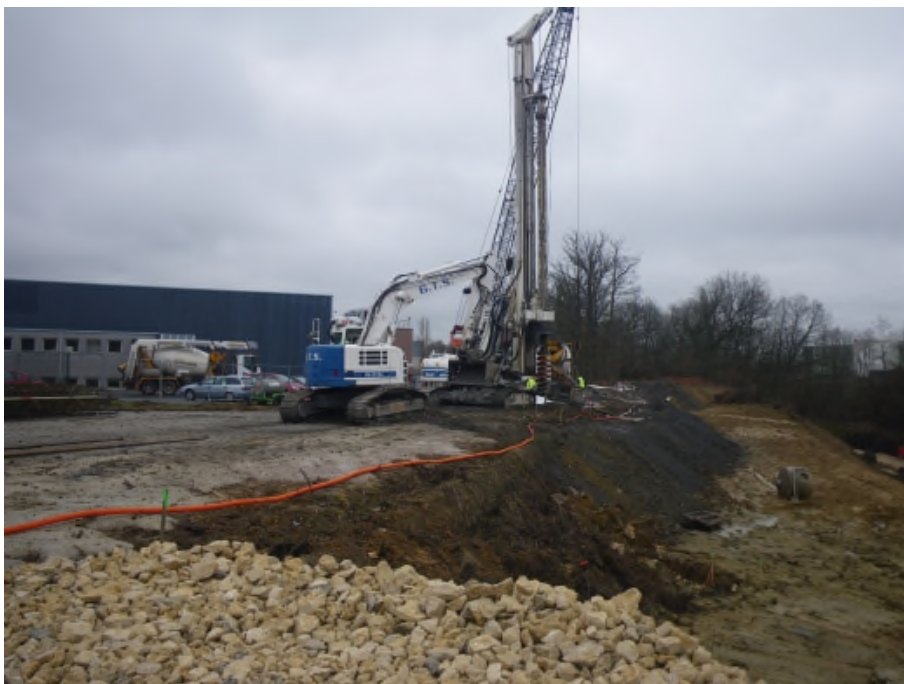
Figure 6 : forage des pieux. Photographie du 25/01/2012.
