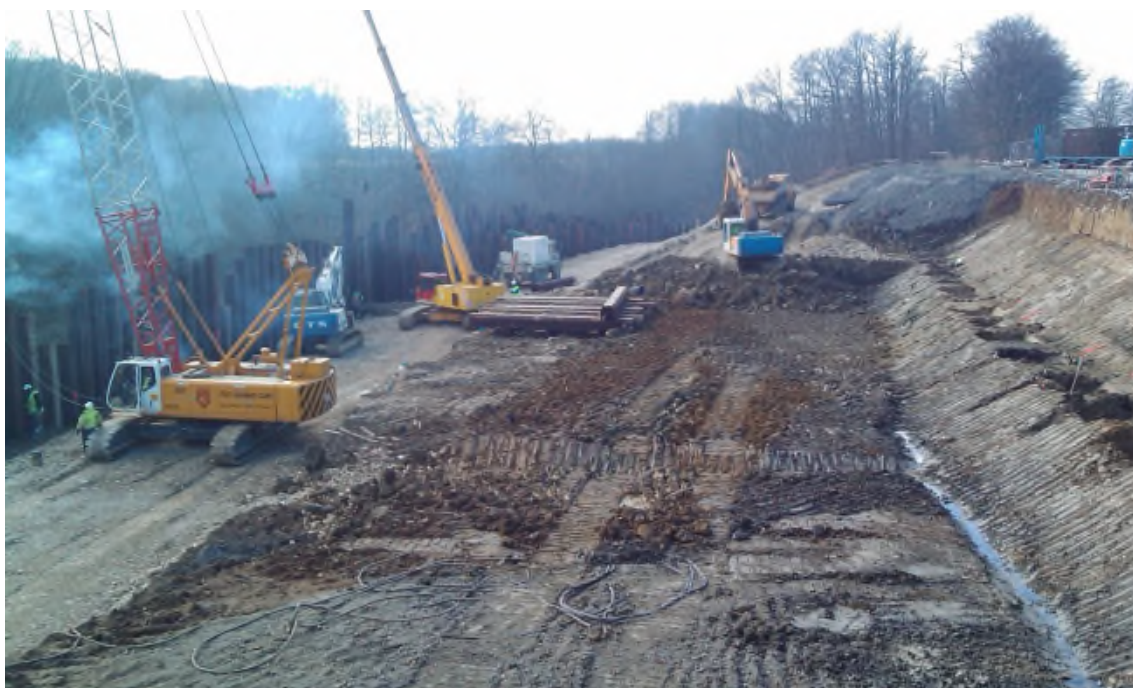
Figure 13 : terrassement et battage des palplanches. 29/02/2012.
