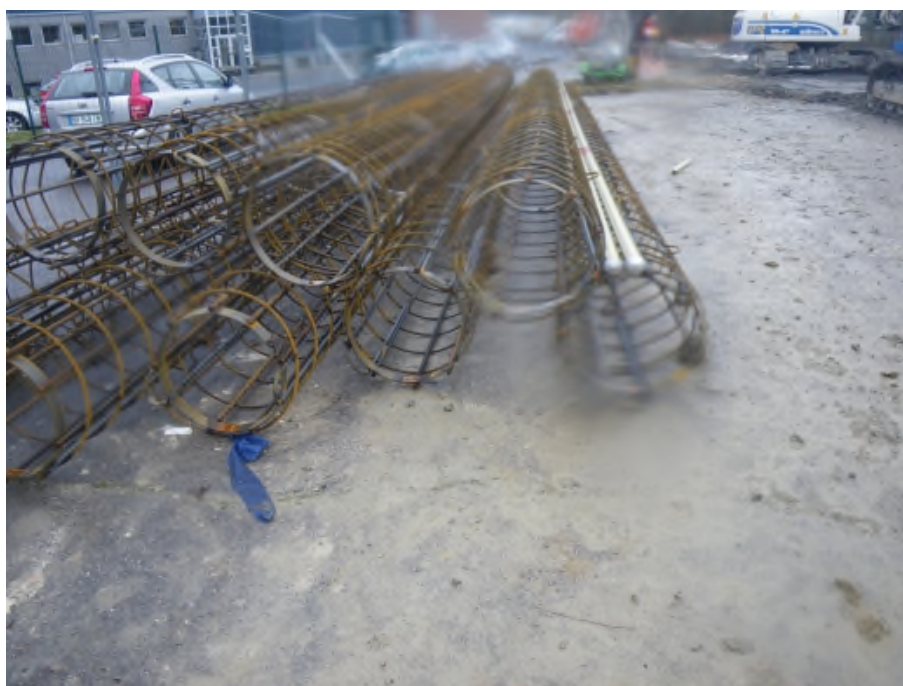
Figure 8 : forage des pieux et cages d'armatures. 25/01/2012.
