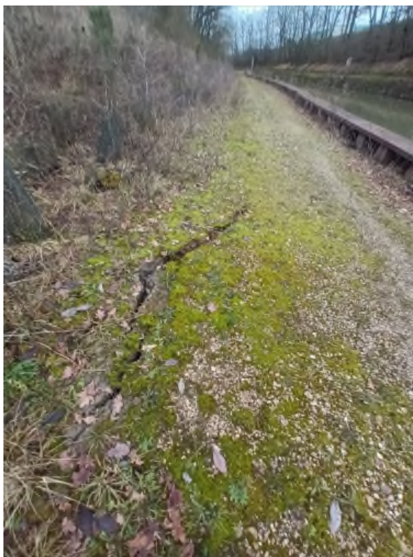
Figure 21 : fissures en pied de talus, signe du mouvement des palplanches. 05/01/2024.
