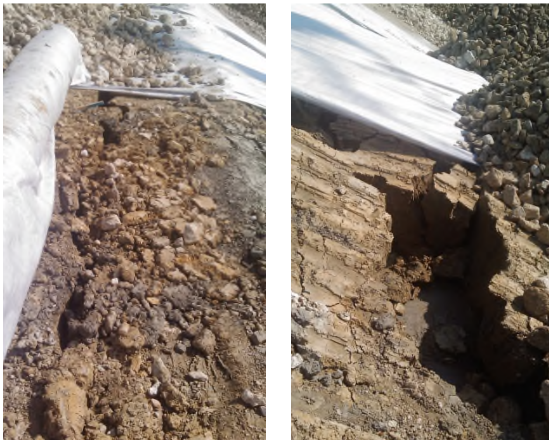
Figure 16 : fissures résiduelles à la base des matériaux glissés, amorcées ou réactivées pendant les travaux.
