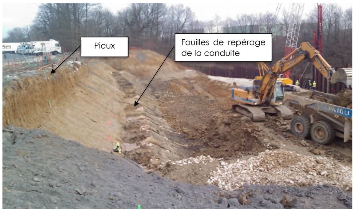
Figure 11 : terrassement après réalisation des pieux et repérage de l'aqueduc. 29/02/2012.
