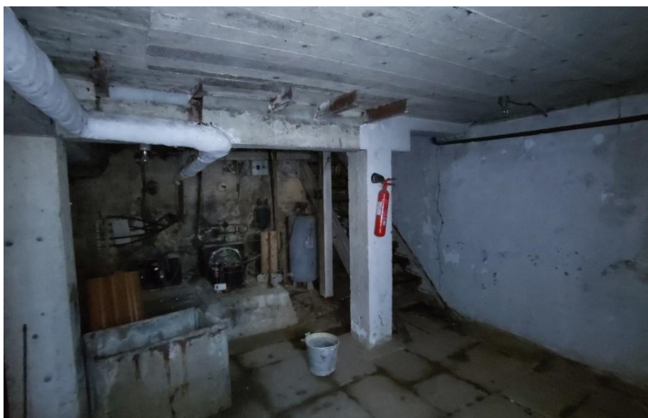
> Sous-sol (accès au bief)
