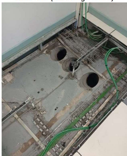
Arrivée dans le bloc technique depuis le caniveau extérieur (carottage D200)
