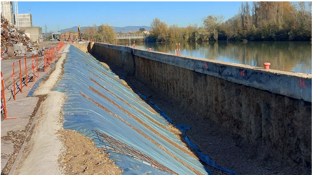
Vue de la partie centrale du quai sinistré, après décaissement.
