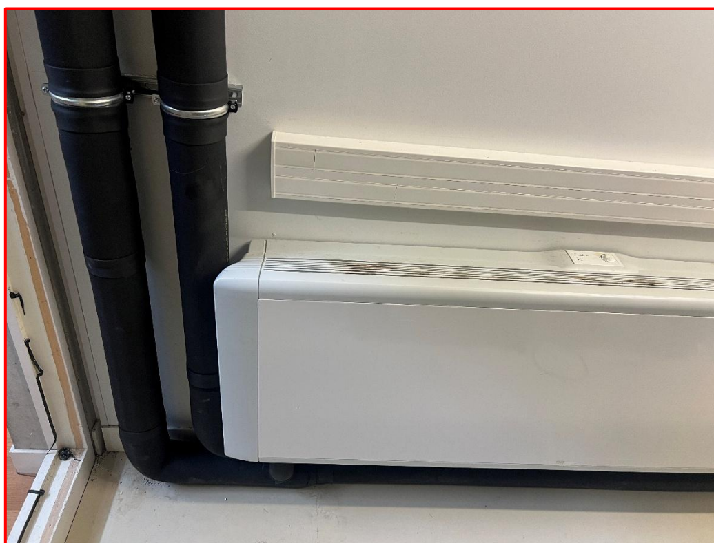
Raccordement ventilo-convecteurs salle serveur
