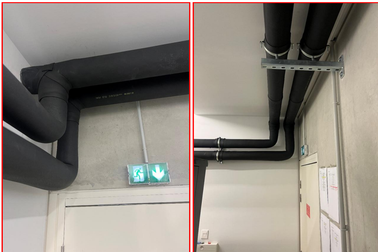
Réseau neuf avec calorifuge
