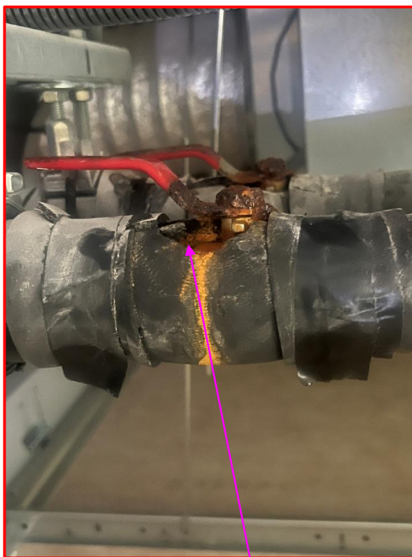
Vannes corrodées et fuyardes Absence de prolongateur de la vanne pour mettre l'isolant
