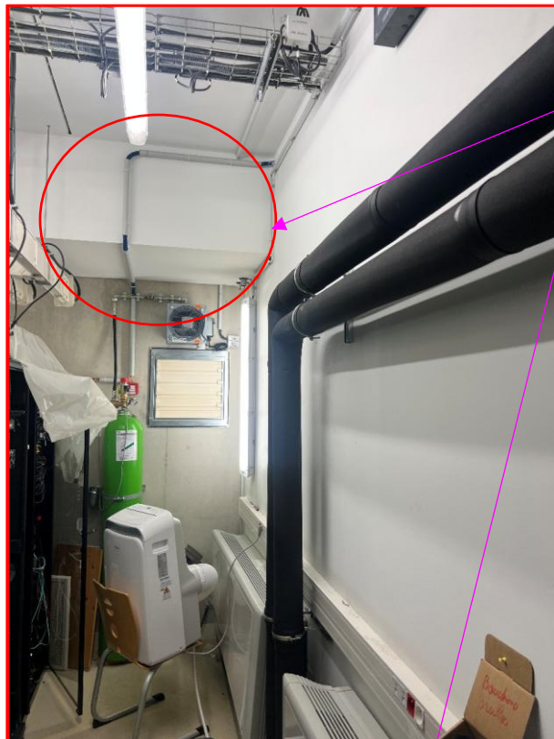
Réseau neuf en salle informatique +calo
