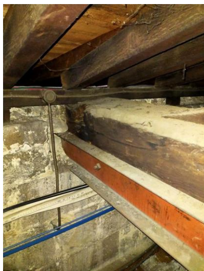
Renfort d'un appui de ferme attachée par un champignon pour reconstituer l'appui
