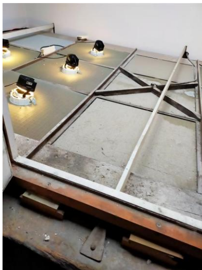
Deux exemples de verrières à nettoyer car quasiment opaques à cause de la poussière
