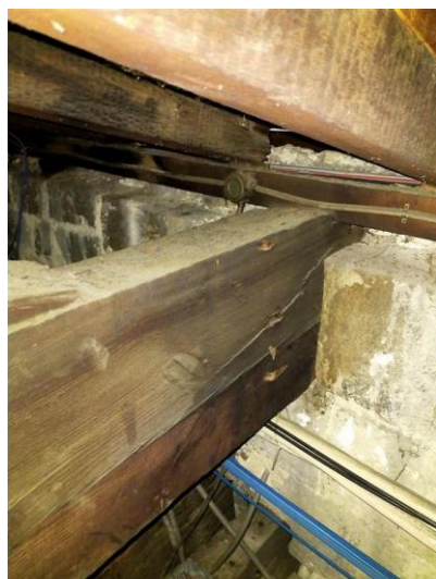
Gerce sur appuis avec traitement par injection
