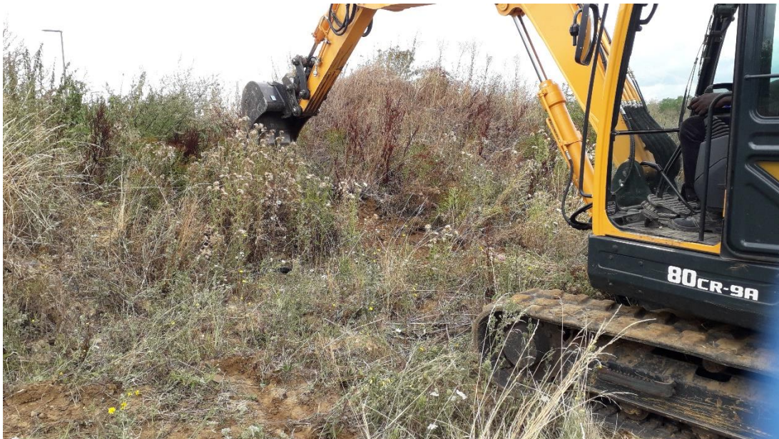
Figure 2 : Réalisation d'un sondage à la pelle mécanique
