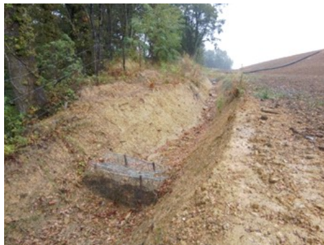
Exemple de fossé équipé de filtre à paille
