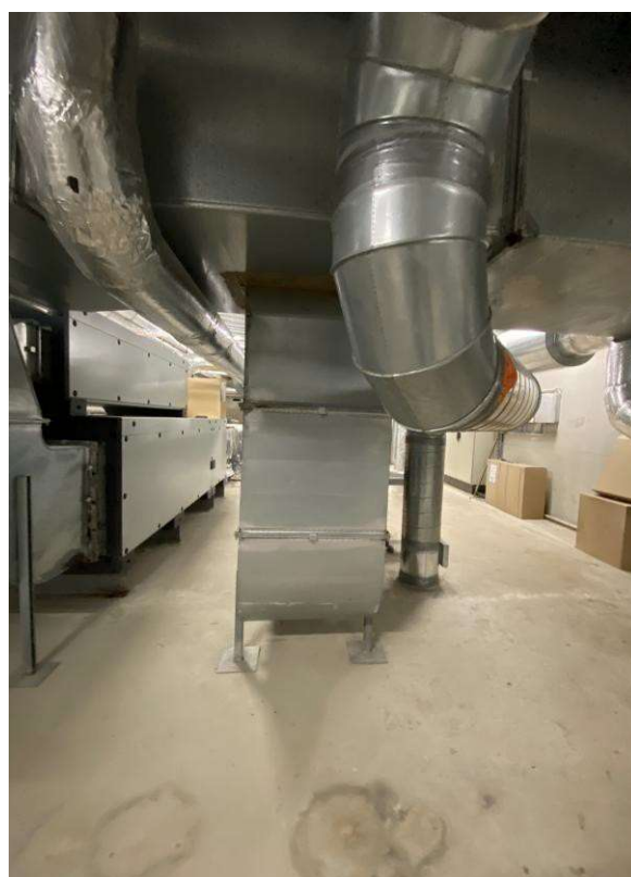
Réseaux de ventilation non calorifugés dans Niveau 2 (Combles Techniques)
