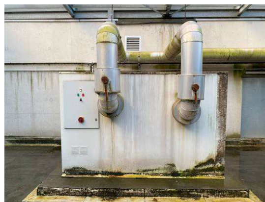
Module hydraulique associé à la production d'eau glacée, équipé d'une bache tampon de 1 500 Litres
