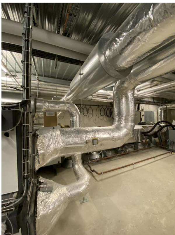
Réseaux calorifugés en sortie de CTA dans Niveau 2 (Combles Techniques)
