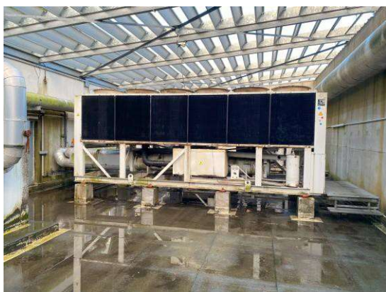
Production d'eau glacée – Niveau Combles Techniques – en Extérieur
