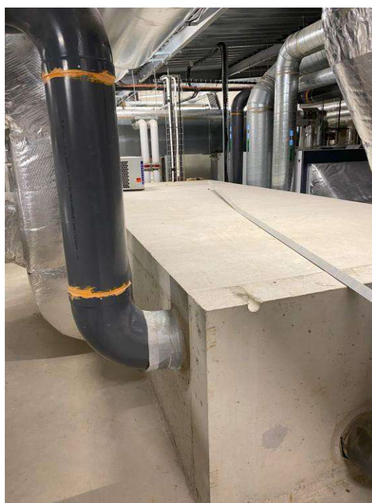
Réseaux de ventilation (CTA et extraction spécifique) pénétrant dans le Niveau Technique depuis un puit technique
