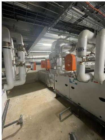
Alimentation Eau Chaude et Eau Glacée des batteries CTA, avec vanne trois voies motorisées
