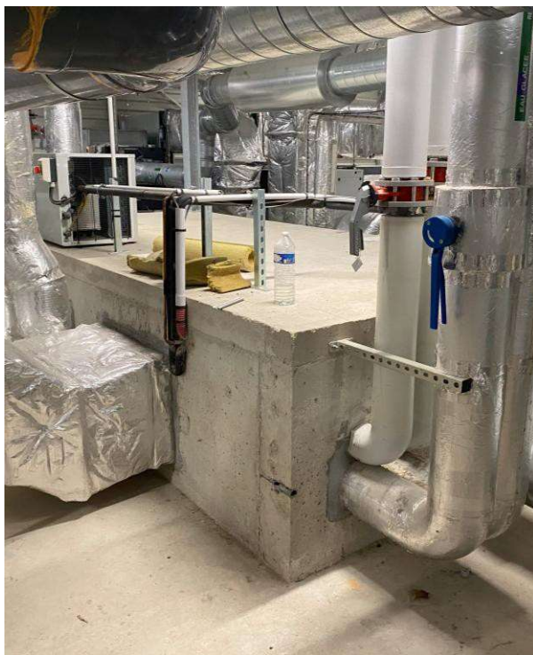
Réseaux hydrauliques et aérauliques pénétrant dans le Niveau Technique depuis un puit technique
