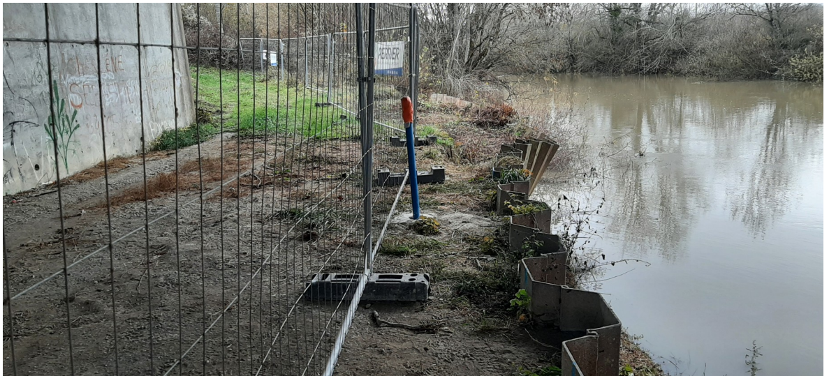
Palplanches avant consolidation
