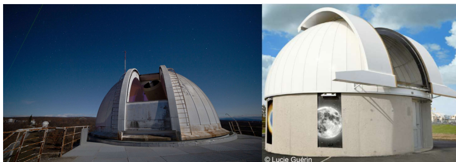
Figure 4: Dôme actuel (à gauche) et coupole de la Cité de l'Espace à Toulouse, présentant un système d'ouverture par translation horizontale des panneaux (à droite)
