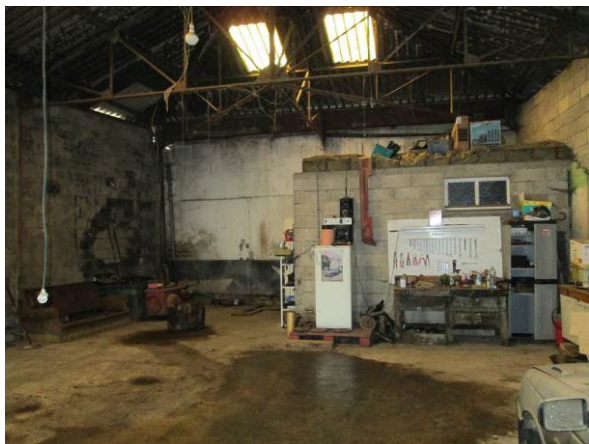
Photo 7 : Vue intérieure du hangar et de la toiture en amiante ciment
