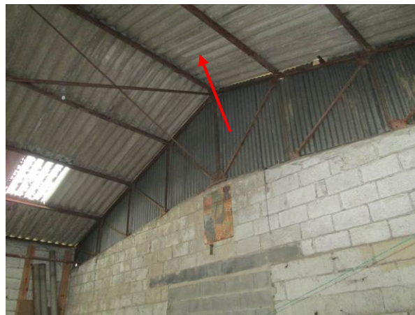
Photo 20 Vue intérieure du pignon Nord. Toiture en tôles ondulées de type amiante ciment et charpente métallique
