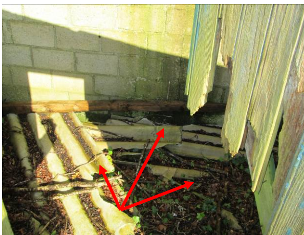
Photo 25 : Vue intérieure du cabanon B et des déchets de toiture en tôles ondulées de type amiante ciment au sol
