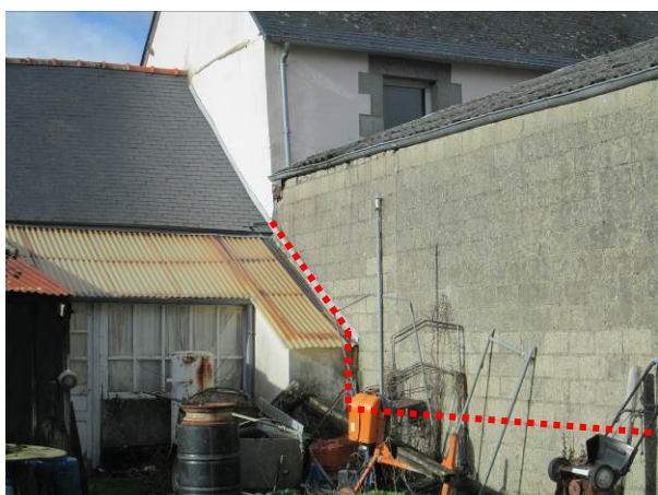
Photo 5 : Vue de la découpe du mur du hangar selon la pente de l'appentis de la parcelle AB81.
