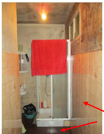
Photo 9 : Vue intérieure de la partie maçonnée à l'intérieur du hangar. Carrelage mural et au sol à soumettre au diagnostic amiante.
