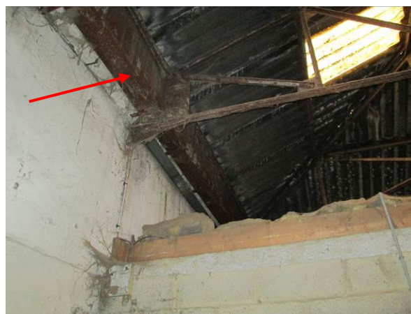
Photo 12 : Vue de la fixation de la charpente du hangar sur la maison d'habitation
