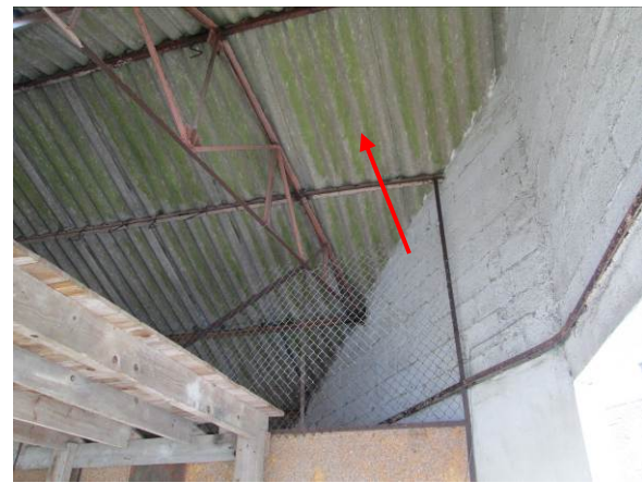
Photo 18 : Vue de la toiture en tôles ondulées de type amiante ciment de la partie Sud du Hangar 2.
