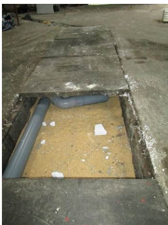
Photo 21 : Vue intérieure du hangar 2 et de la fosse mécanique remplie de grave parpaings et sable
