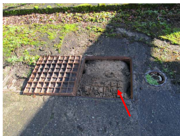
Photo 27 : Vue du sable d'inertage de la cuve enterrée.
