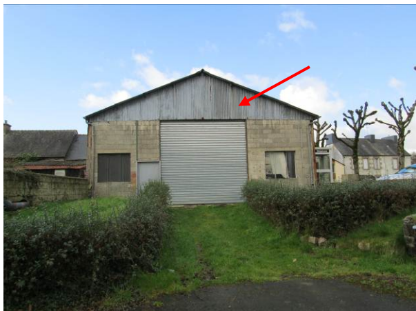
Photo 1 : Vue du bâtiment hangar de la parcelle AB78. Pignon Est. Vue de la partie supérieure en bardage métallique
