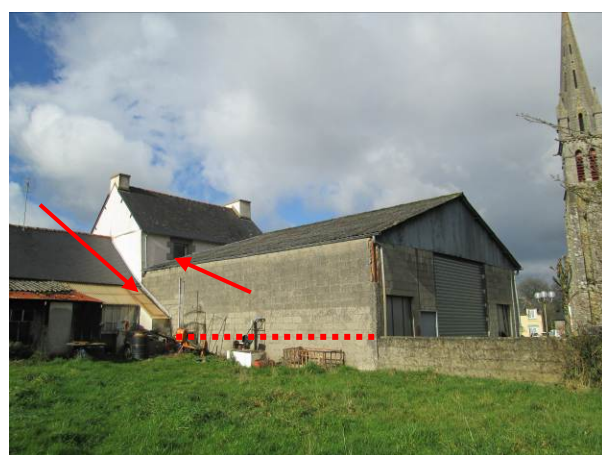
Photo 6 : Vue des mitoyennetés à traiter et de la découpe du mur du hangar selon la hauteur du muret
