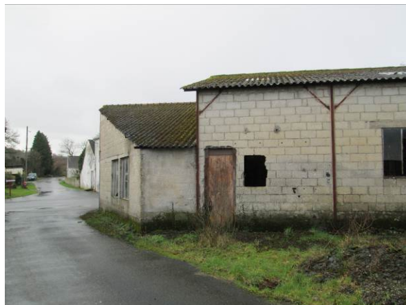
Photo 14 : Vue de l'angle et de la façade Est. Vue des toitures en tôles ondulées de type amiante ciment.
