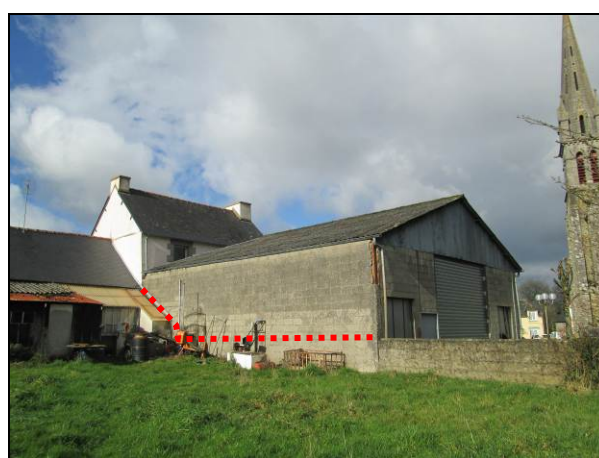
Vue de la découpe du mur de parpaings le long de la toiture du bâtiment mitoyen
