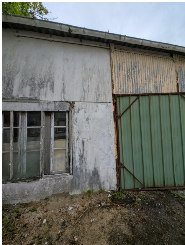
FACADE AVEC BARDAGE AMIANTE - GARAGE
