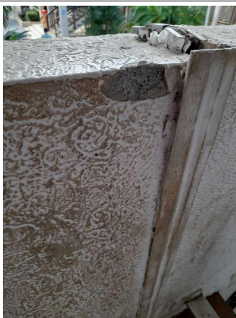
Prélèvement - P007 : Cour d'appel / Extérieur / Façade - Enduit - (Présence d'amiante)
