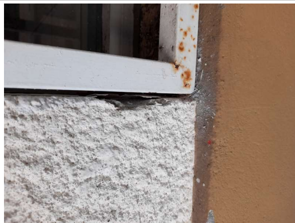
Prélèvement - P002 : Cour d'appel / Extérieur / Façade - Enduit - (Présence d'amiante)
