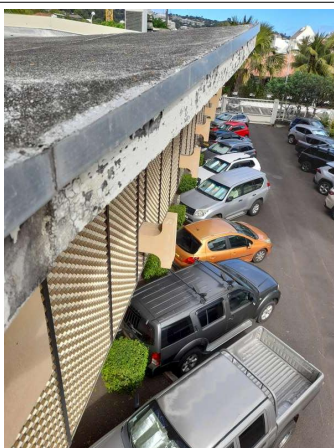
Prélèvement - P017 : Cour d'appel / Extérieur / Façade - Enduit - (Présence d'amiante)
