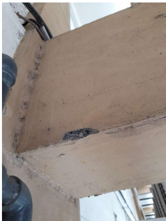
Prélèvement - P005 : Cour d'appel / Extérieur / Façade - Enduit - (Absence d'amiante)
