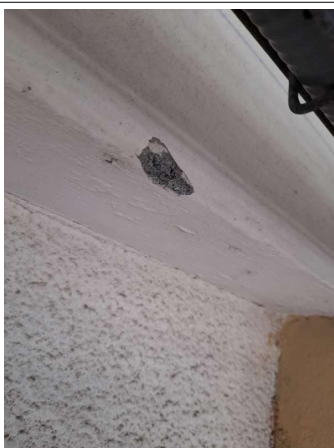
Prélèvement - P011 : Cour d'appel / Extérieur / Façade - Enduit - (Présence d'amiante)
