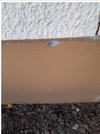
Prélèvement - P001 : Cour d'appel / Extérieur / Façade - Enduit - (Absence d'amiante)
