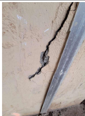
Prélèvement - P010 : Cour d'appel / Extérieur / Façade - Enduit - (Présence d'amiante)
