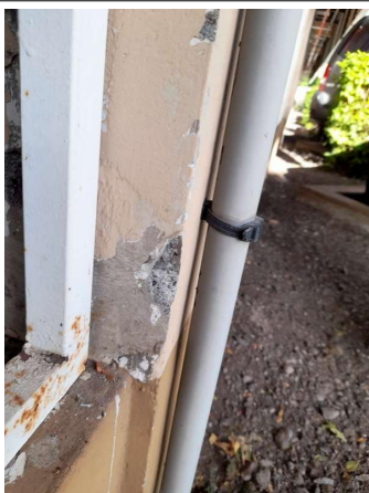
Prélèvement - P003 : Cour d'appel / Extérieur / Façade - Enduit - (Présence d'amiante)
