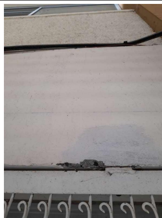
Prélèvement - P004 : Cour d'appel / Extérieur / Façade - Enduit - (Présence d'amiante)
