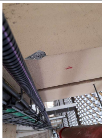
Prélèvement - P012 : Cour d'appel / Extérieur / Façade - Enduit - (Présence d'amiante)
