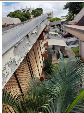
Prélèvement - P016 : Cour d'appel / Extérieur / Façade - Enduit - (Présence d'amiante)
