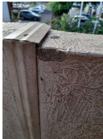
Prélèvement - P006 : Cour d'appel / Extérieur / Façade - Enduit - (Présence d'amiante)
