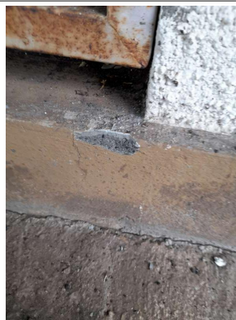
Prélèvement - P008 : Cour d'appel / Extérieur / Façade - Enduit - (Présence d'amiante)
