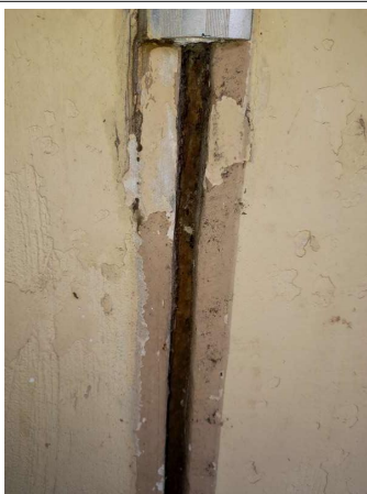
Prélèvement - P013 : Cour d'appel / Extérieur / Façade - Joint de structure- (Absence d'amiante)
