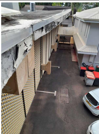
Prélèvement - P015 : Cour d'appel / Extérieur / Façade - Enduit - (Présence d'amiante)
