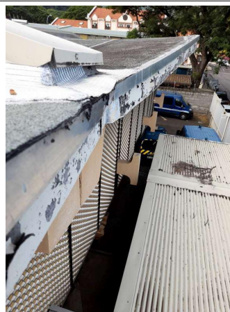
Prélèvement - P014 : Cour d'appel / Extérieur / Façade - Enduit - (Présence d'amiante)
