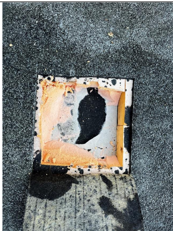
Photographie 5 : Trémie dans le complexe d'étanchéité
