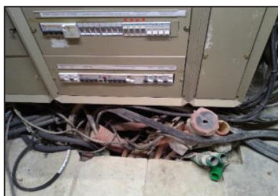
Figure 21 : Fourreaux présents en pied d'armoire
