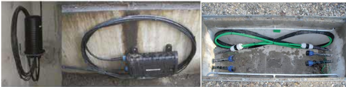
Exemple de lovage et de boîte d'épissures (BPEO)
