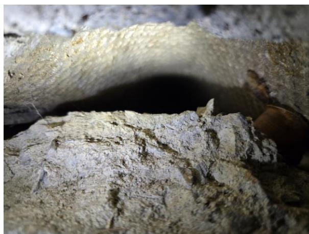
Vue des coffrages perdus en amiante-ciment bâtiment C
