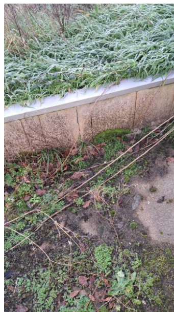
Vue des plaques de soubassement amianteciment
