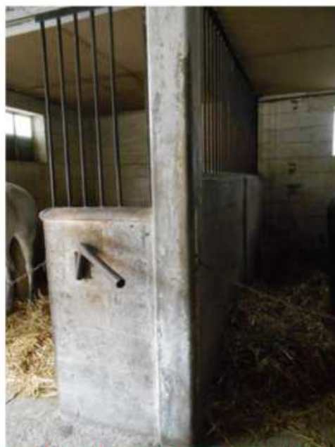
Dégagement 1 (Haras) - Poteaux poutres - Poteaux habillés fibre ciment
