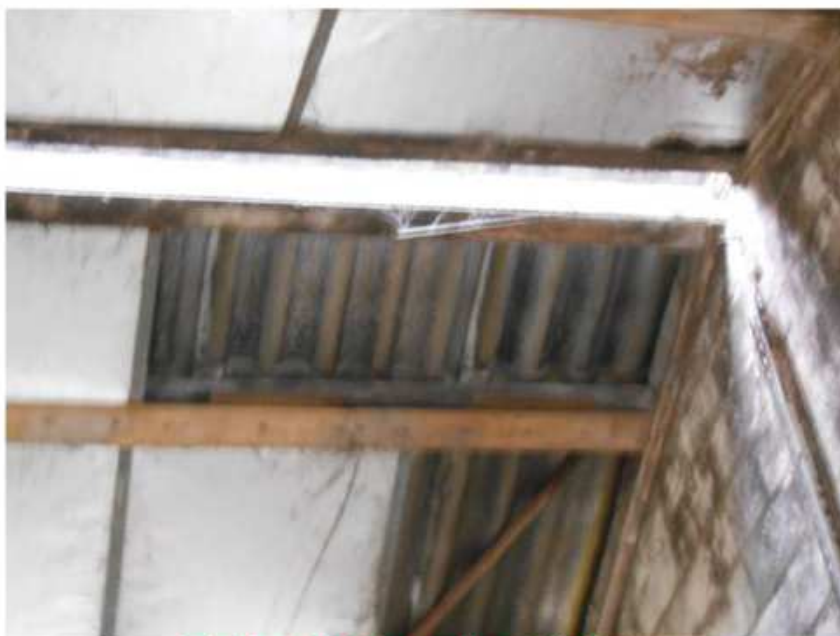
Enclos (Bergerie 1) - Couverture - Tôles ondulées fibrociment
