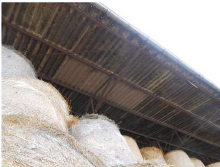
Espace stockage (Hangar 2) - Couverture - Tôles ondulées fibrociment
