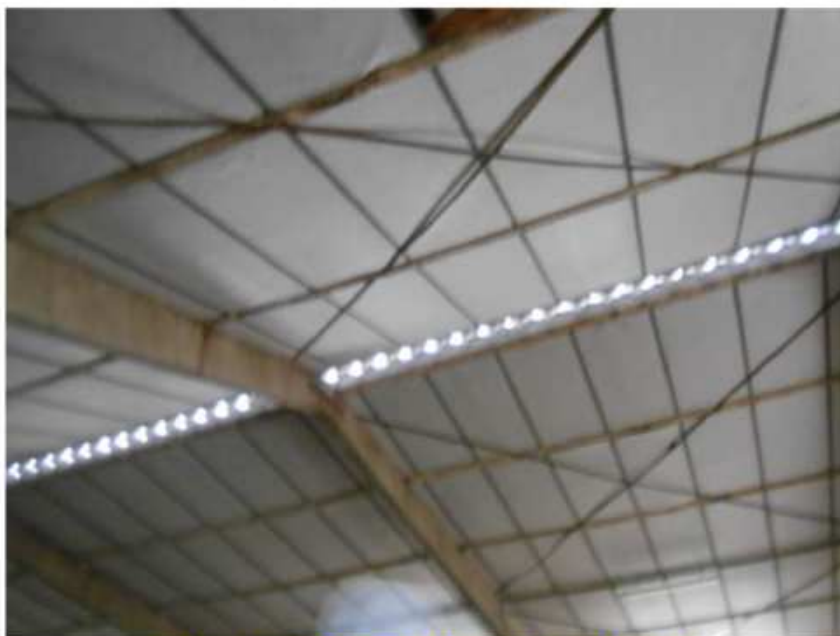
P4 - Enclos (Bergerie 2) - Plafond - Faux plafond en dalles suspendues
