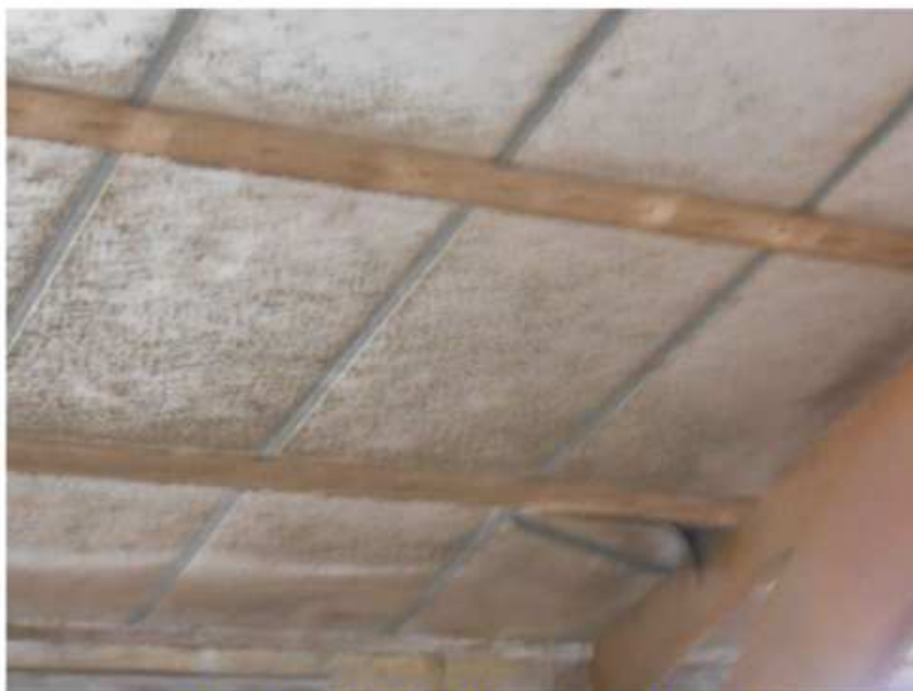
P3 - Enclos (Bergerie 1) - Plafond - Faux plafond en dalles suspendues
