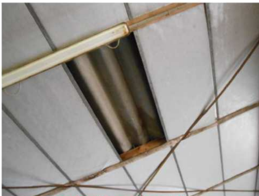
Enclos (Bergerie 2) - Couverture - Tôles ondulées fibrociment
