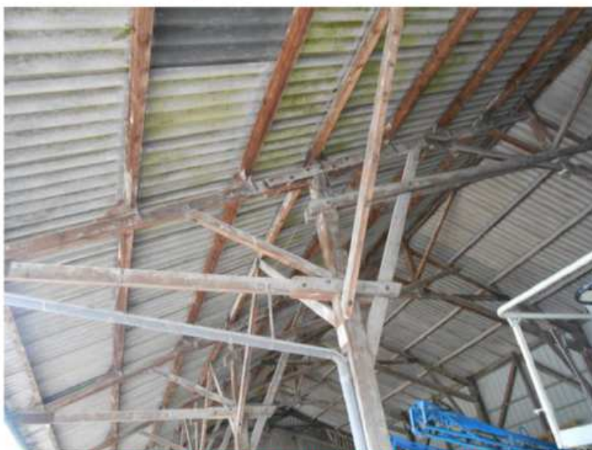
Espace stockage 2 (Hangar 1) - Couverture - Tôles ondulées fibrociment
