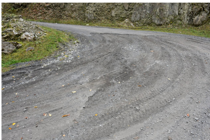
Reprise du tri-couche sur la largeur de la chaussée (virages notamment)
