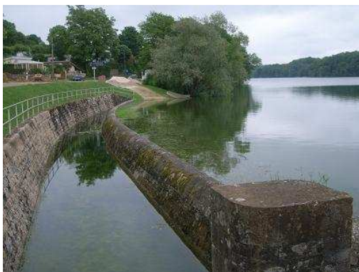
Réservoir de Charmes – détails du déversoir de crue.
