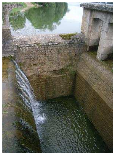
Réservoir de Charmes – détails du déversoir de crue.
