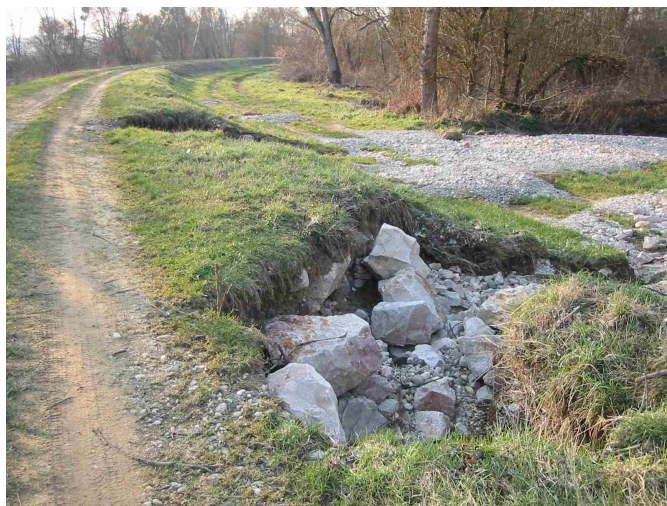
Figure 13 : Exemple de digue en enrochements + remblai (photo JR Malavoi)
