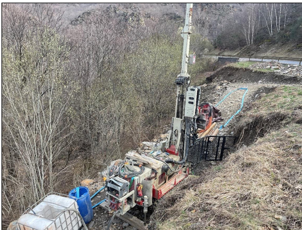
Atelier de forage sur site – sondage 22-SCA1 - Source : Géolithe 21/03/2023
