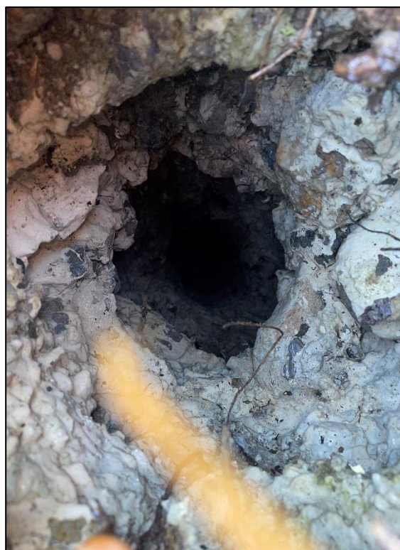
Photos de désordre de l'absence du capot métallique de SCB1
