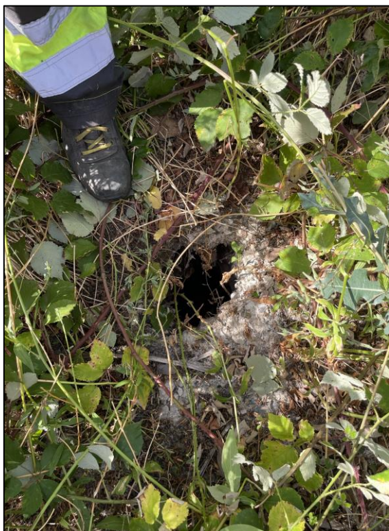
Photos de désordre de l'absence du capot métallique de SCB1
