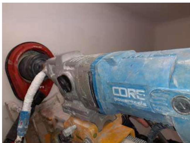
Image 8 : percement à l'aide d'une perceuse à eau et d'un système de récupération (détail). ©AD Marne
