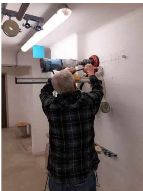
Image 7 : percement à l'aide d'une perceuse à eau et d'un système de récupération. ©AD Marne
