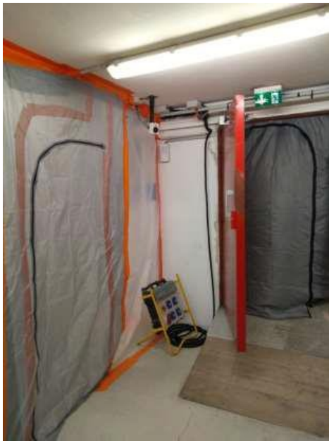
Image 1 : isolement des espaces par porte zippée. ©AD Marne
