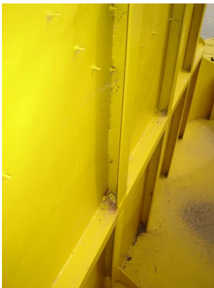
Figure 185 : Légère corrosion dans armatures internes de la baignoire, zone de stagnation (2007)
