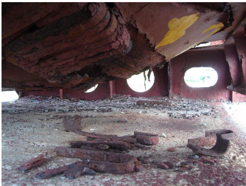
Figure 125 : Dessous de la sphère, corrosion des agrafes dès 2007
