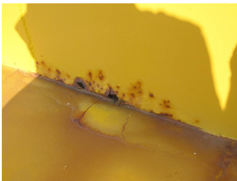
Figure 184 : Corrosion en pied de baignoire, 2018
