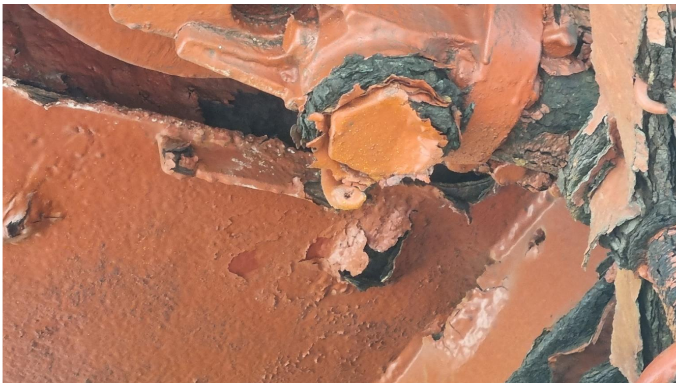
Figure 100 : Dessous de carène, au-dessus de la sphère, détail de corrosion sur boulonnerie 2025
