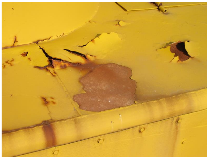
Figure 178 : Ecaillage de peinture, disparition de la galvanisation et corrosion substrat acier, 2018
