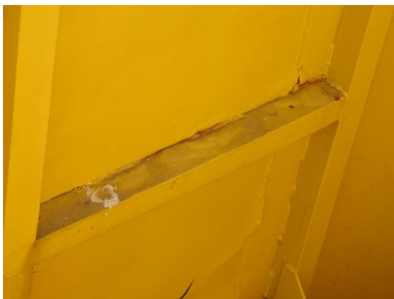
Figure 186 : Ecaillage de la peinture et légère corrosion dans armatures internes de la baignoire, zone de stagnation 2018
