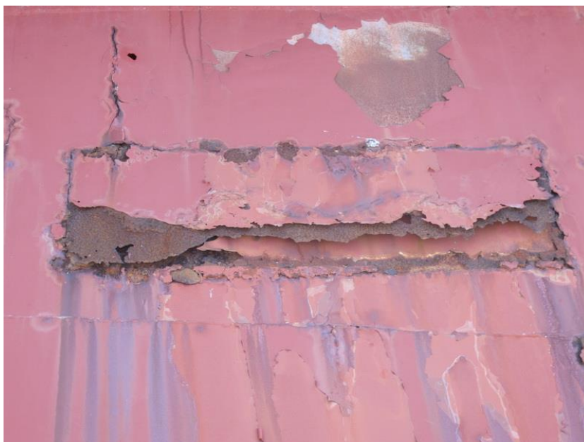
Figure 130 : Détail du stabilisateur tribord et sa réparation par soudure en 2018
