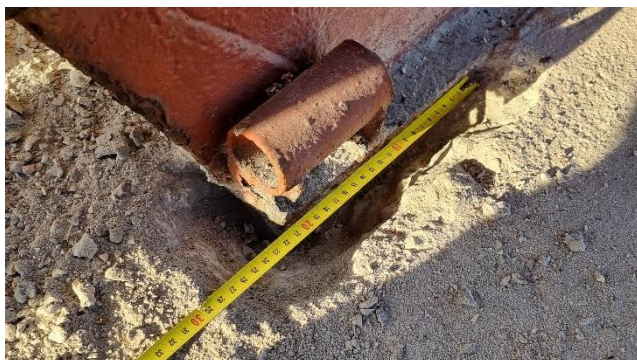
Figure 45 : Dégagement du cadre inférieur de la charpente
