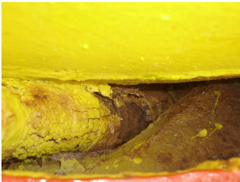
Figure 123 : Agrafes de serrage de la sphère / socle en 2007
