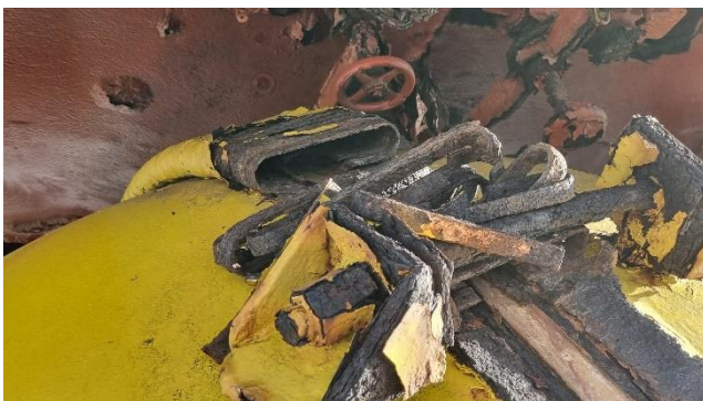
Figure 38 : détail d'agrafes corrodées, désassemblées de la 1/2 sphère, sur la partie haute
