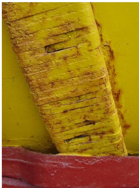
Figure 117 : Agrafes de serrage de la sphère / socle en 2007
