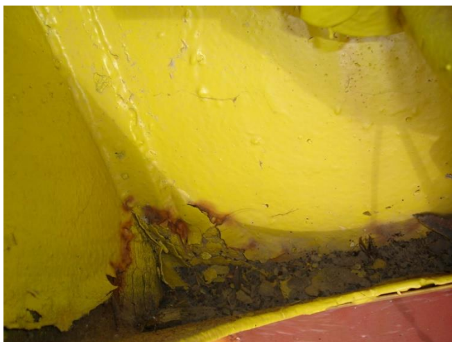
Figure 153 : Détail de l'intérieur du bloc-hélice bâbord, zone de rétention d'eau, corrosion (2007 – 2018)
