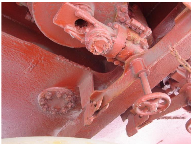
Figure 97 : Dessous de carène, au-dessus de la sphère, détail corrosion en 2007 (gauche) et 2018 (droite)
