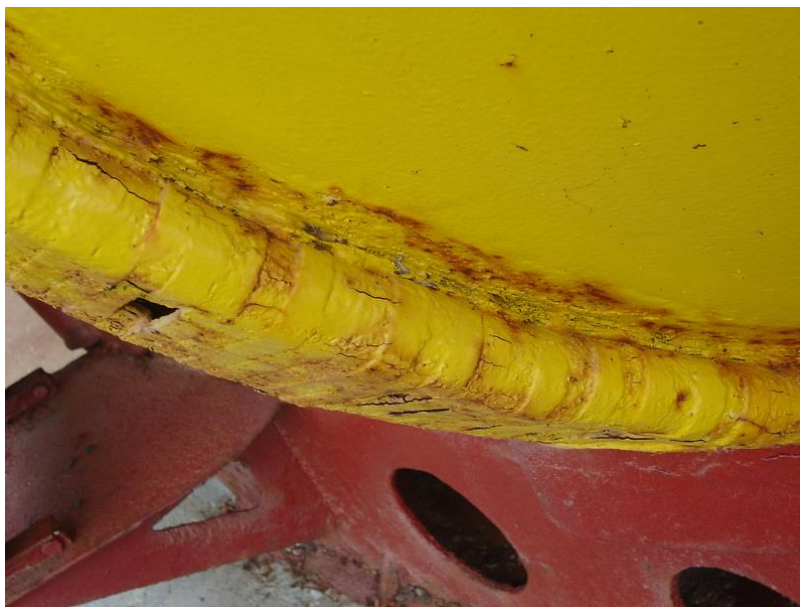
Figure 119 : Agrafes de serrage de la sphère / socle en 2007
