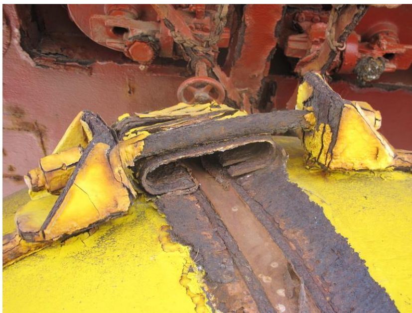
Figure 124 : Agrafes de serrage de la sphère / socle en 2018
