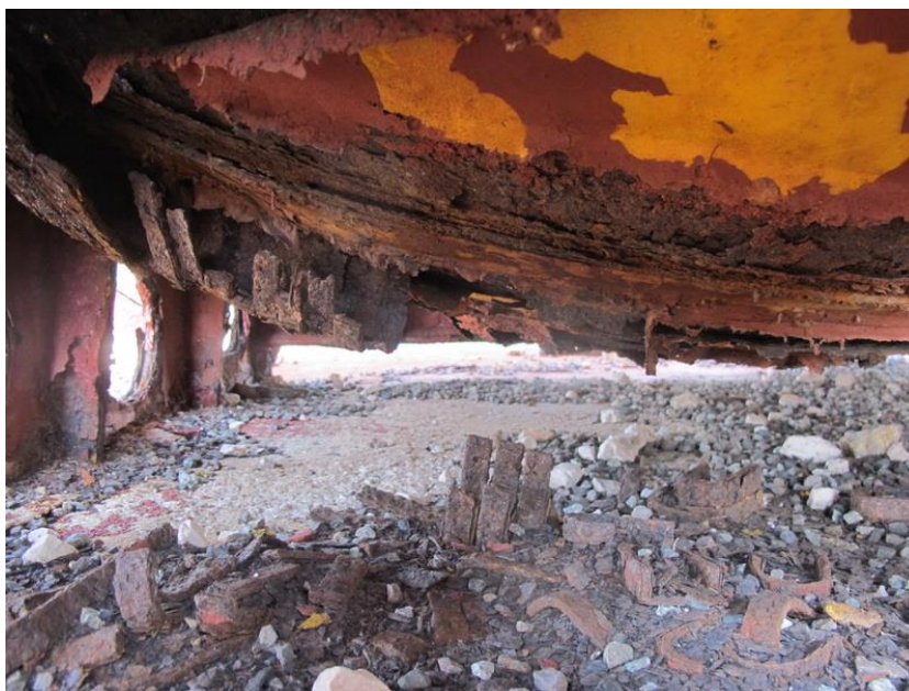
Figure 126 : Dessous de la sphère, corrosion des agrafes en 2018
