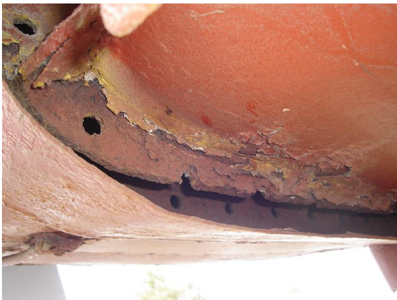
Figure 137 : Détail du sas d'entrée, corrosion d'une zone de jonction en 2007
