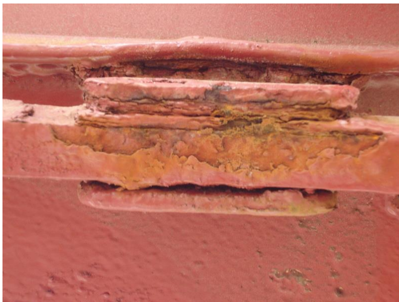
Figure 143 : Détail de la corrosion d'une soudure du caisson en 2007
