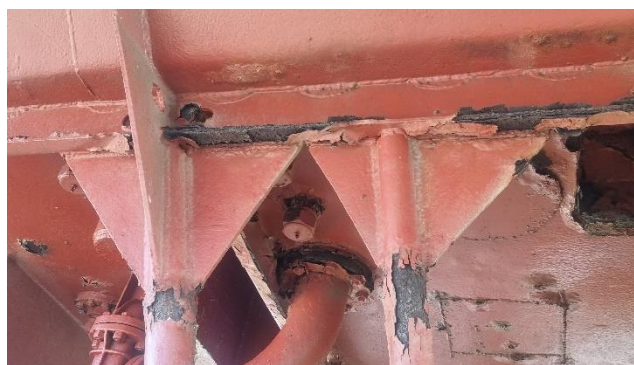
Figure 42 : charpente : cadre supérieur et détail de la semelle inférieure corrodée de l'IPN ainsi que les montants
