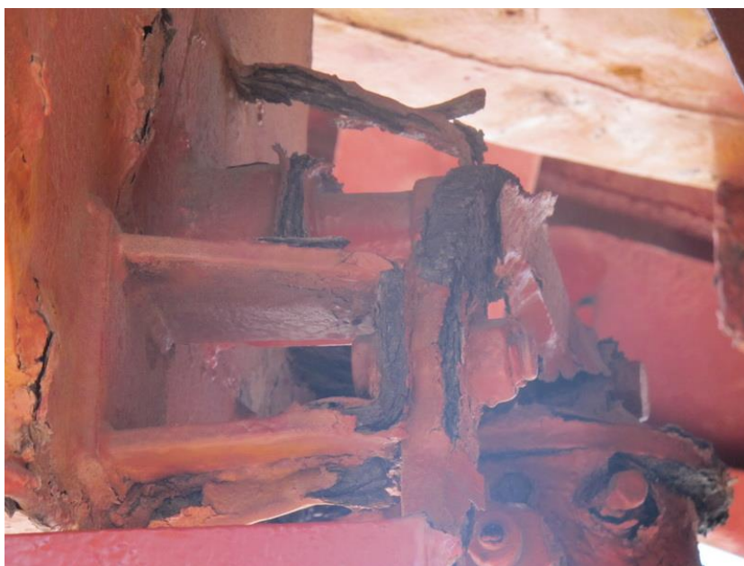
Figure 146 : Détail de la corrosion d'un tube carré du caisson en 2018
