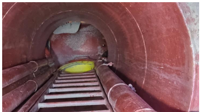
Figure 16 : Echelle d'accès à l'entrée de la sphère depuis la baignoire
