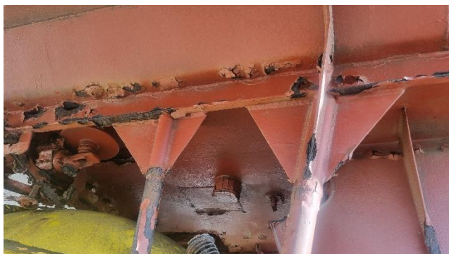
Figure 43 : Détail des montants et IPN supérieur corrodés
