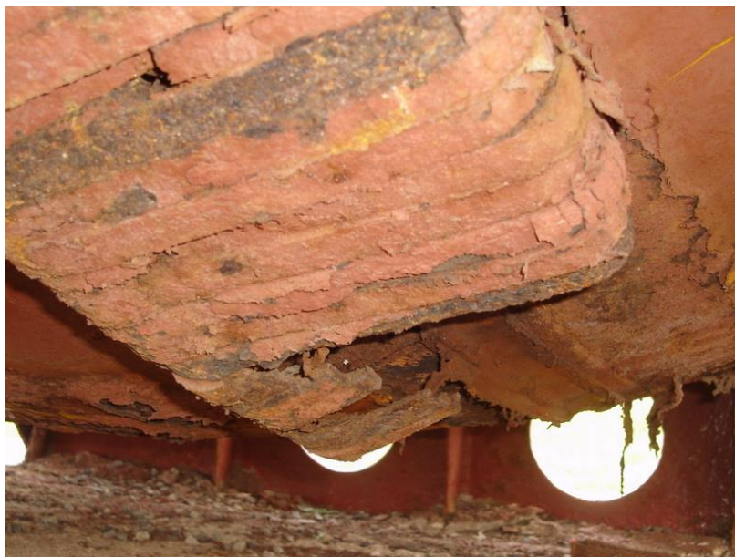
Figure 127 : Dessous de la sphère, corrosion des agrafes dès 2007
