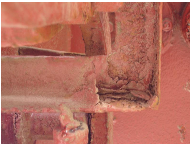
Figure 145 : Détail de la corrosion d'un tube carré du caisson en 2007
