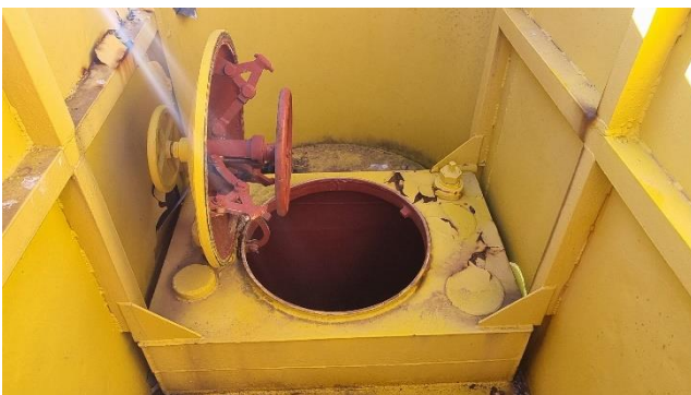
Figure 15 : Ecouille située dans la baignoire pour accéder à la sphère
