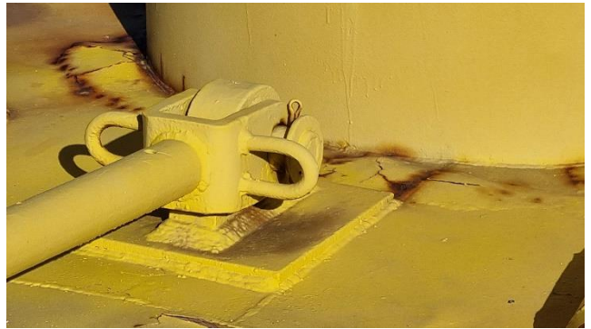
Figure 14 : détail de l'anneau de levage, soudures conformes
