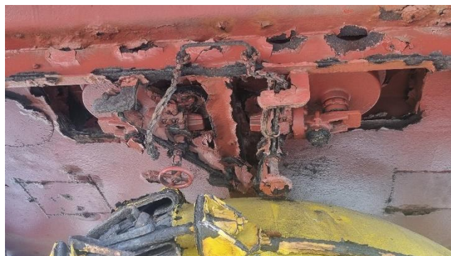
Figure 44 : Autre détail de corrosion
