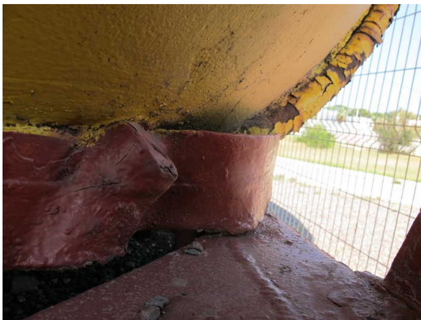
Figure 122 : Agrafes de serrage de la sphère / socle en 2018
