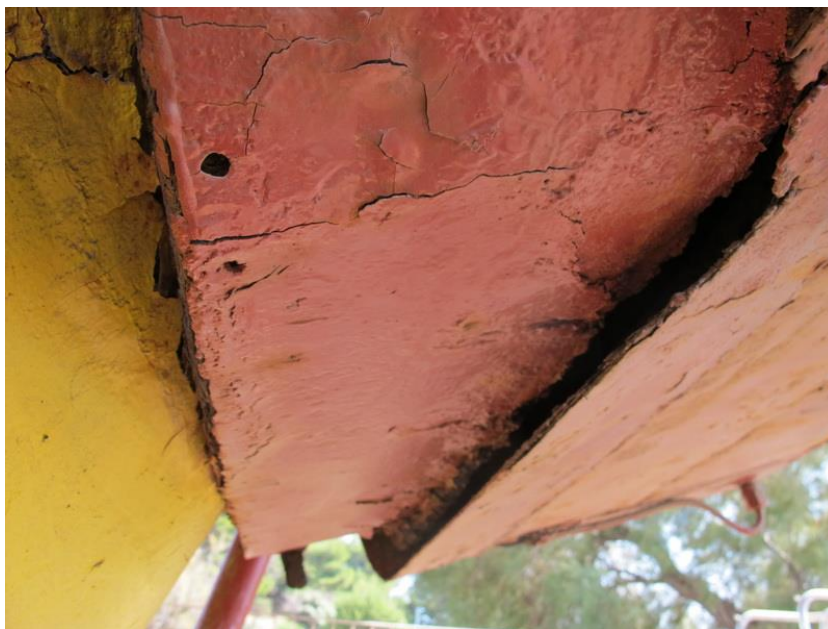
Figure 138 : Détail du sas d'entrée, corrosion d'une zone de jonction en 2018
