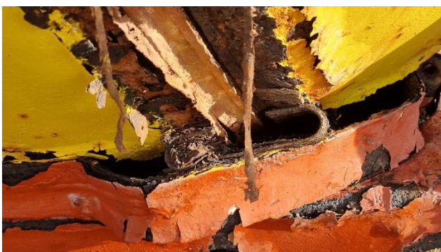
Figure 39 : Détail des agrafes disparues en partie basse
