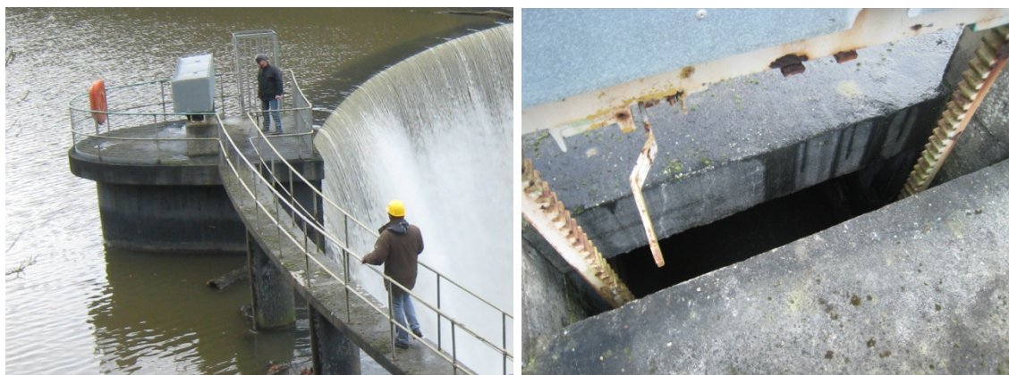
Figure 3.25 Dispositif de manœuvre de la vidange de demi-fond
