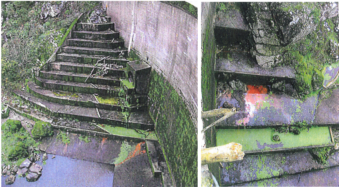
Figure 7.11 Eau ferrugineuse sur les redans en 2009
