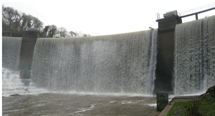
Figure 3.1 Surverse permanente du barrage de Pont Rolland
