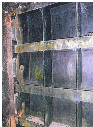
Figure 7.19 Tablier aval de la vanne de secours en 2011
