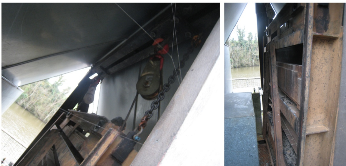
Figure 3.22 Batardeau maintenu en position haute par une chaîne
