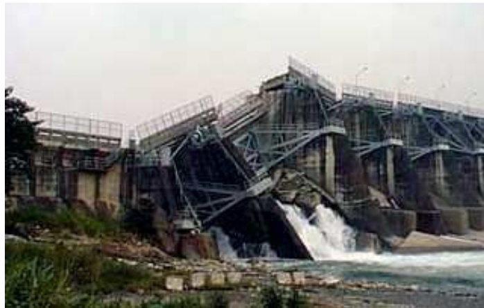
Figure 7.8 Barrage de Shih Khang après le séisme Chi Chi – rupture au droit de la faille
