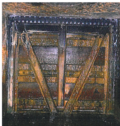
Figure 7.18 Tablier aval de la vanne de fond et blindage acier en 2011
