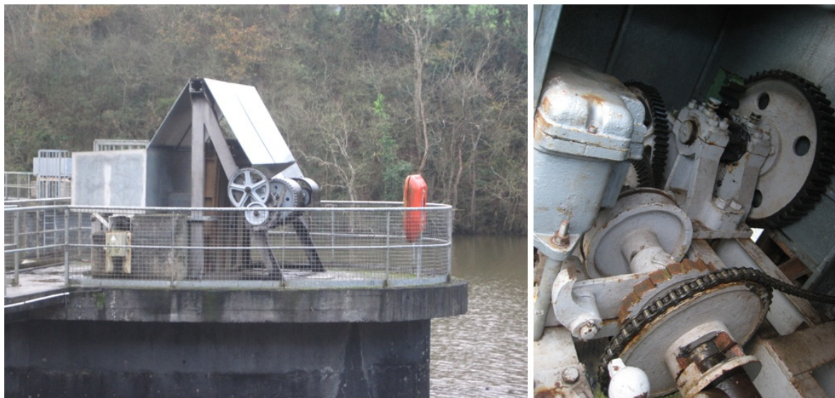
Figure 3.21 Dispositif de manœuvre de la vanne de fond protégé par un abri en tôle
