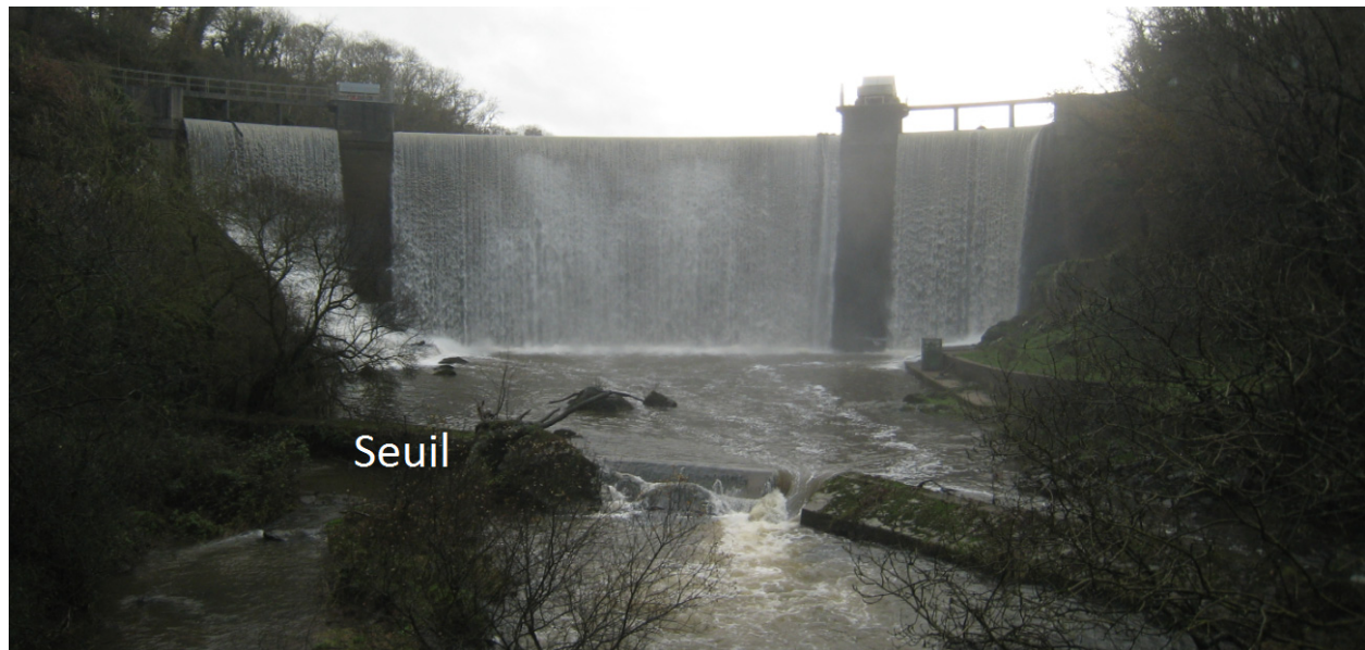
Figure 3.12 Seuil à l'aval du barrage
