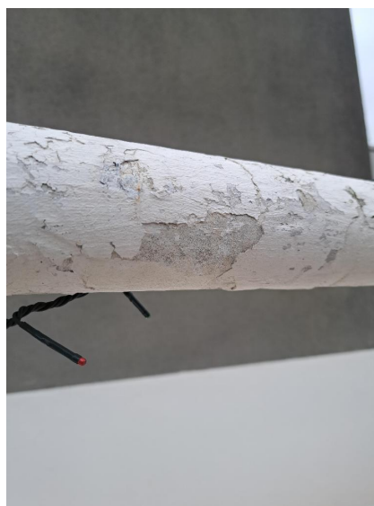
Extérieur : Conduit amiante ciment poteaux de cloture
