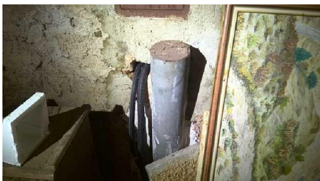
Grenier 1 : Conduit d'air en amiante ciment
