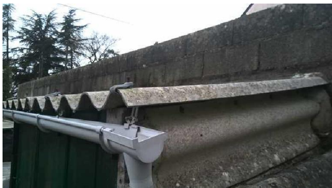
Abri 1 : Couverture et bardage en plaque amiante ciment
