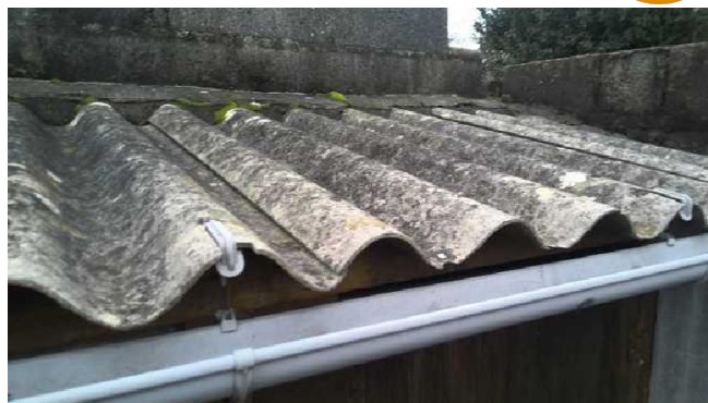
Abri 2 : Couverture en plaque amiante ciment
