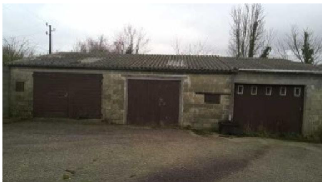
Garage 01, Garage 02, Garage 03: Couverture en tôles amiante ciment
