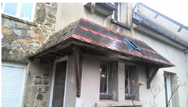
Auvent : Couverture en ardoise amiante ciment
