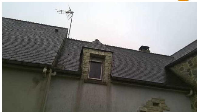
Toiture : couverture en ardoises amiante ciment
