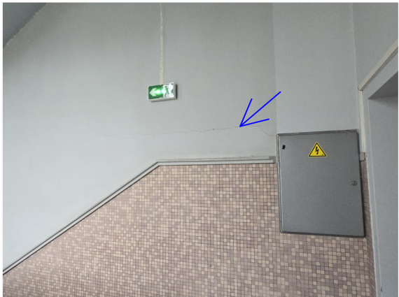
10 - Fissure traversante dans mur en parpaing
