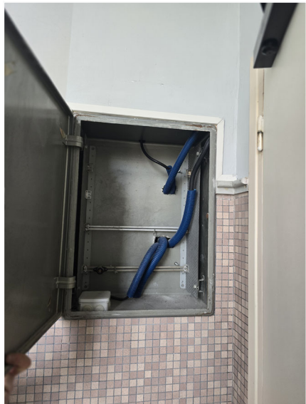
9 - Absence de coupe-feu au droit du coffret électrique
