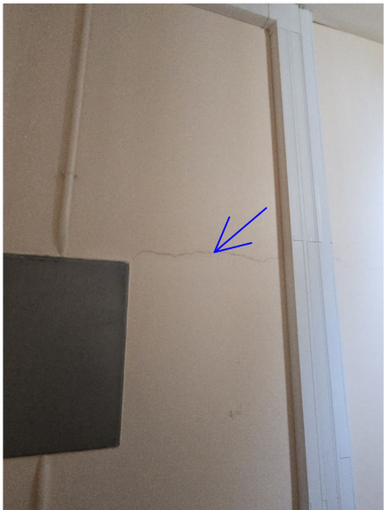
11 - Fissure traversante dans mur en parpaing
