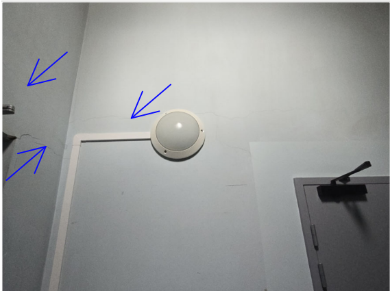
20 - Fissure dans mur en béton (à gauche) et en parpaing (à droite)
