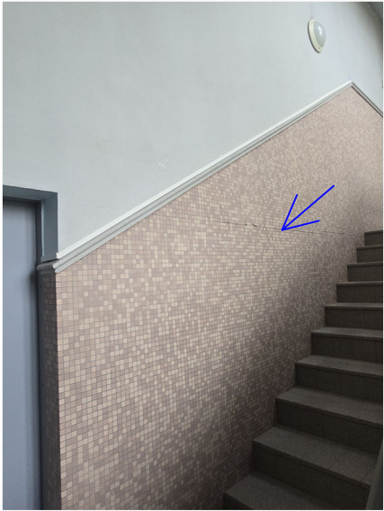
12 - Fissure dans mur en parpaing
