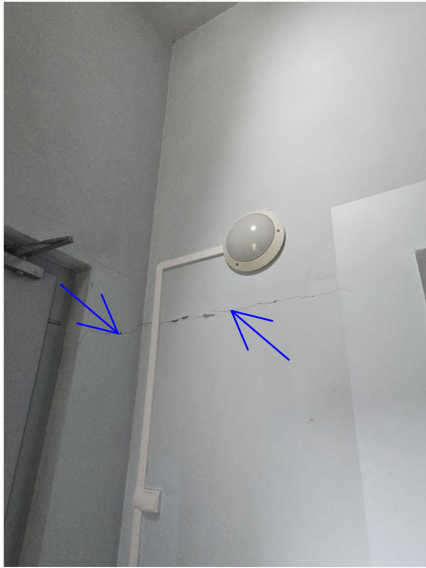
14 - Fissure dans mur en béton (à gauche) et en parpaing (à droite), sondage à réaliser
