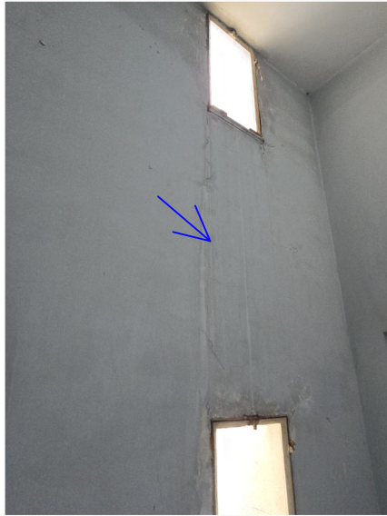
16 - Couleure par châssis non étanche
