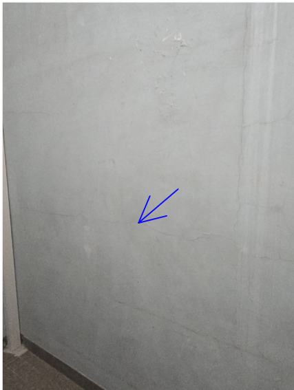
19 - Fissure dans mur en béton
