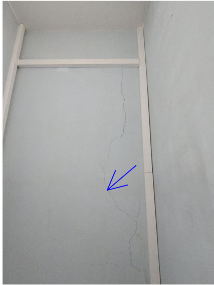
15 - Fissure dans mur en béton
