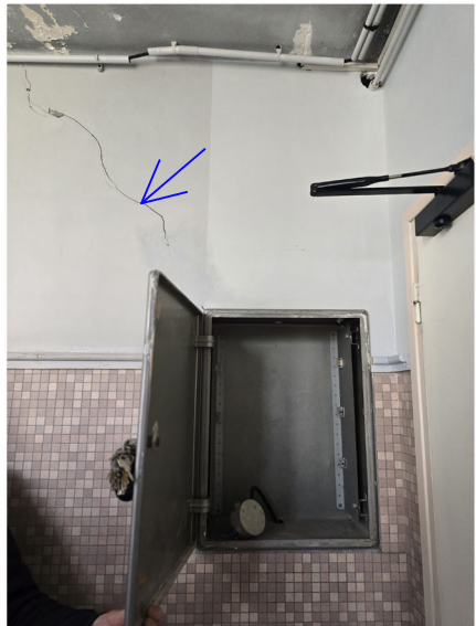
17 - Fissure dans mur en parpaing Absence de coupe-feu au droit du coffret
