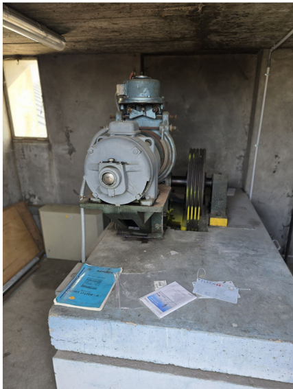
23 - Machinerie d'ascenseur sur socle béton
