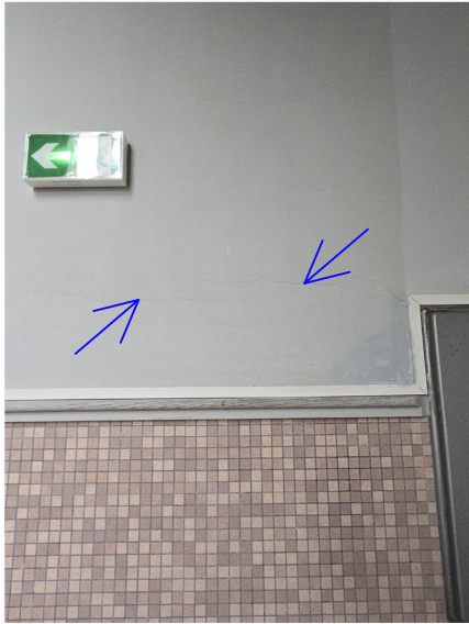
13 - Fissure traversante dans mur en parpaing
