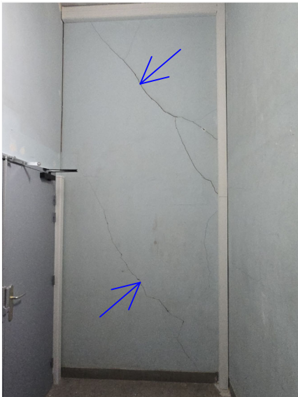
18 - Fissure dans mur en béton
