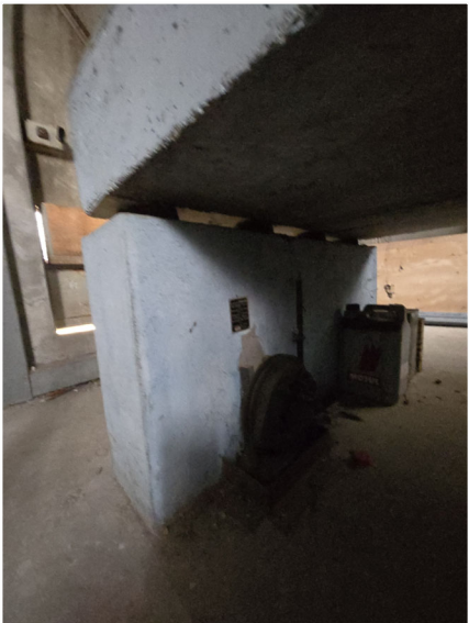
21 - Machinerie d'ascenseur - socle béton
