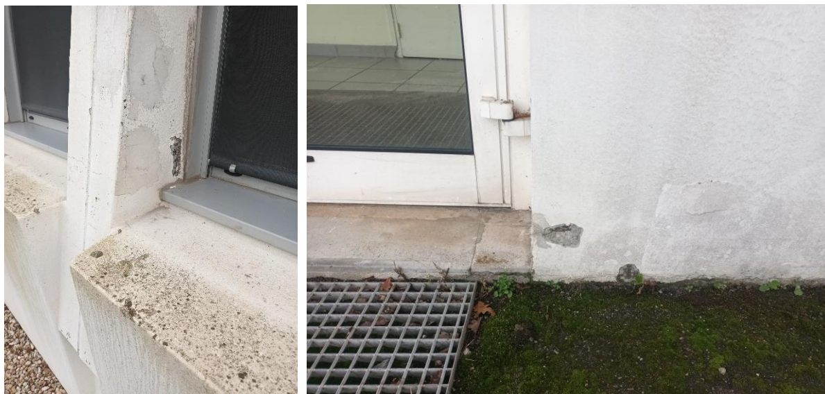
Une enveloppe bâtie qui présente des désordres apparents sur les aciers
