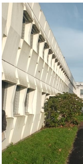
Une isolation thermique non performante avec une façade au profil accidenté ne permettant pas une isolation aisée par l'extérieure
