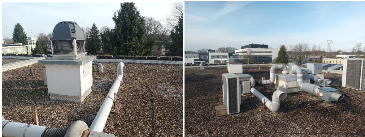
Des ventilations spécifiques rejetant les polluants à hauteur de la toiture terrasse
