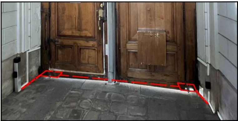
Nouveau passage encastré au sol pour les câbles des photocellules
