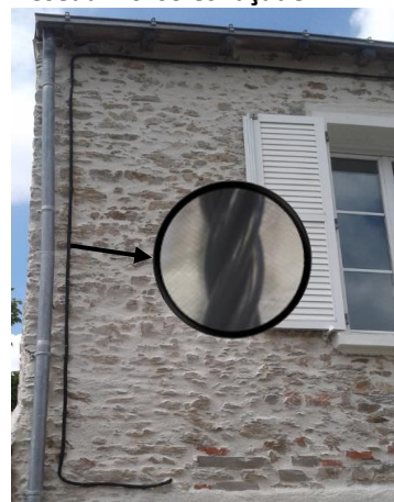
Réseau fils isolés façade BT
