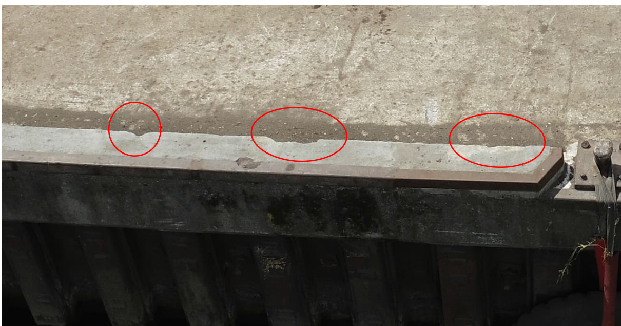
Reprise C1 (Reprise d'angle + remplacement de la cornière)
