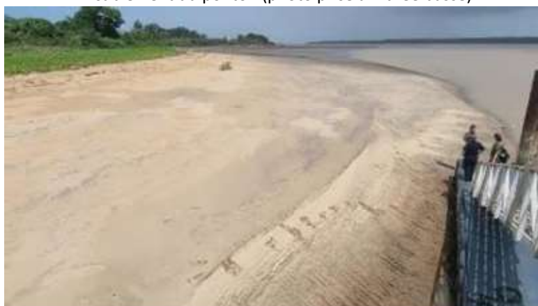
Cordon dunaire en formation provoquant l'ensablement du ponton (photo prise à marée basse)
