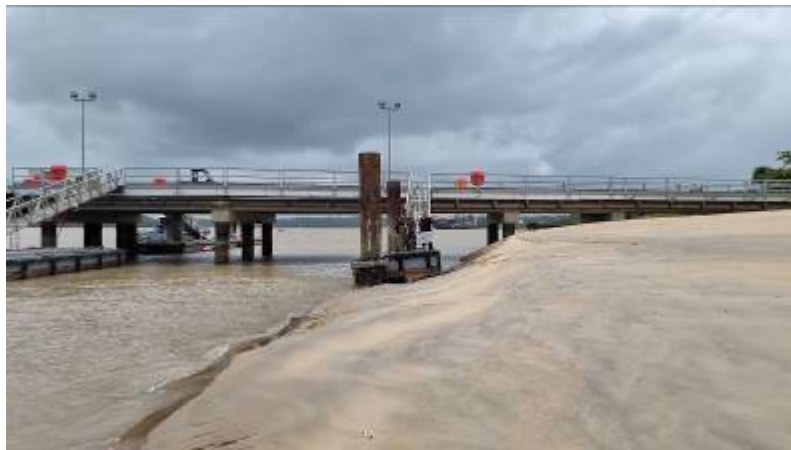
Ensablement arrivant dans la souille à bateau (photo prise à marée basse)
