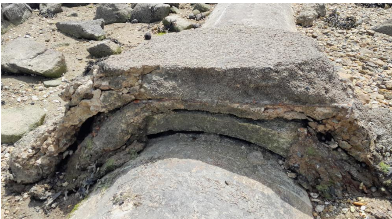
Figure 20 : Exemple de collerette dégradée
