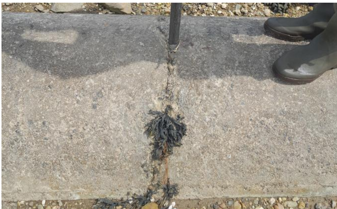
Figure 19 : Exemple de fissure superficielle à réparer
