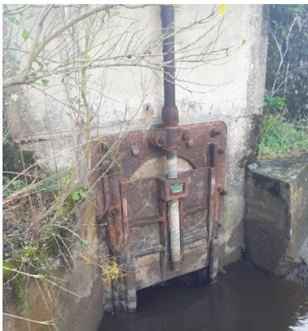
Figure 22 : A gauche : vanne à déposer/ à droite : clapet à déposer
