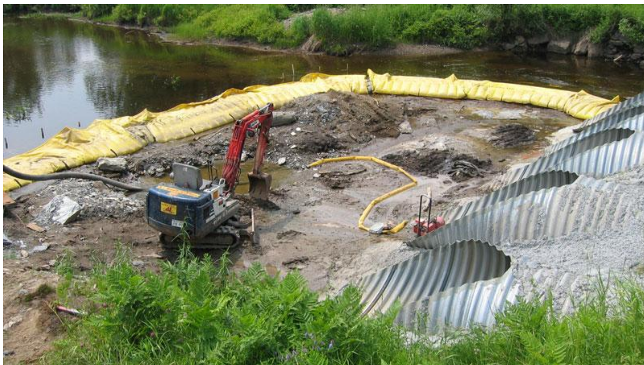
Figure 10 : Exemple de batardeau souple flottant
