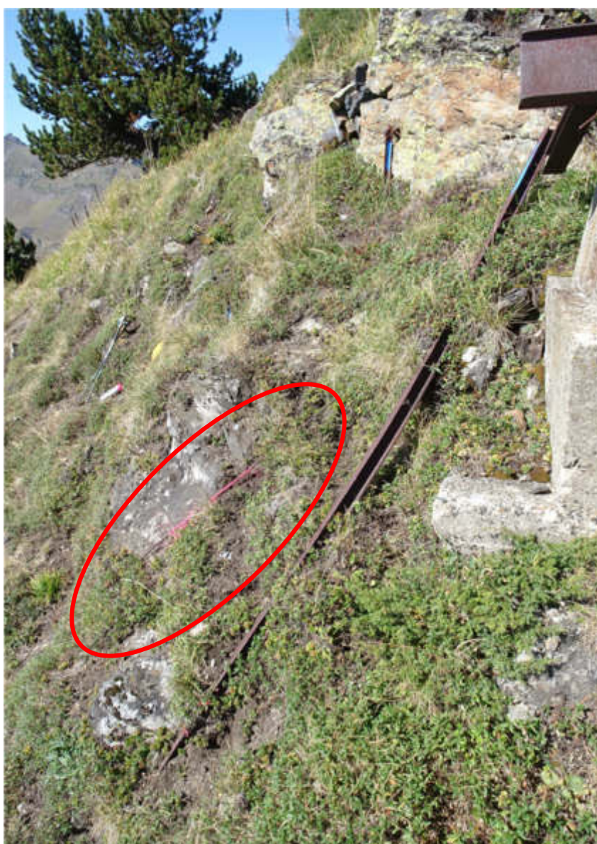
Rails, double câble partiellement enfoui longueur estimée 2x20 ml
