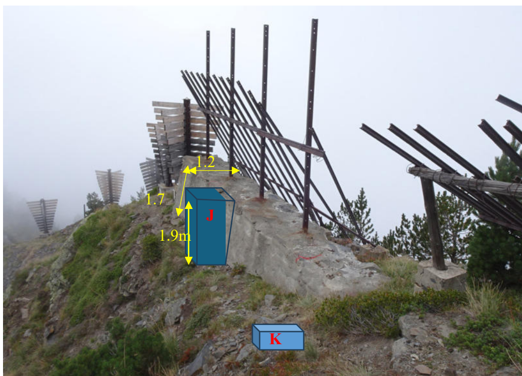
Illustration n°5 : représentation des socles des vire-vents B, C, D sur l'atterrissement d'une banquette (banquette de hauteur 1.7 m et de largeur 1.2 m). Représentation des socles des vire-vents J (hauteur 1.9 m) et K
