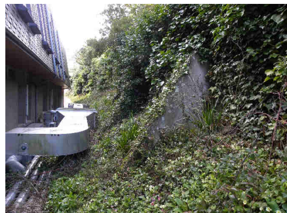
Photo 16 – Murs N°3 à N°7 – Vue depuis le RDC Haut. Contrefort au droit du mur N°7. Mur de soutènement courrette bâtiment
