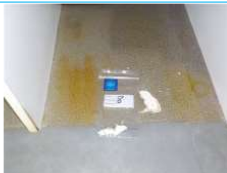
Matériaux : ZPSO-008 Prélèvement : P008 Description : Colle Localisation : Sous-Sol - Local Centrade Résultat : Absence d'amiante
