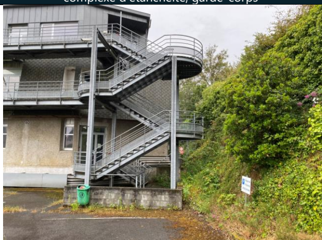
Retrait des escaliers métalliques d'accès extérieurs
