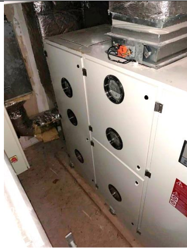
Caissons et gaines de ventilation
