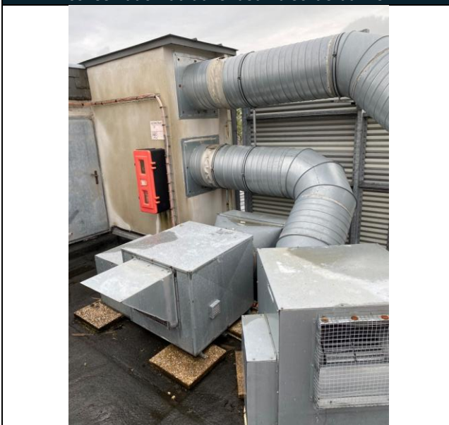
Retrait des réseaux ventilation, extraction, câbles, équipements en toiture / conservation cheminées, complexe d'étanchéité, garde-corps
