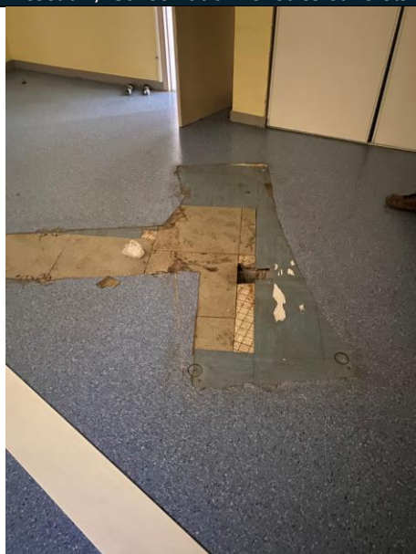
Retrait cloisons, doublages, sols toutes couches, plafonds, équipements, réseaux
